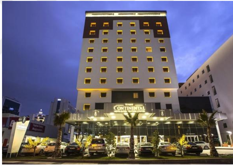
Şekil 29 : Gaziantep Teymur Continental Otel
