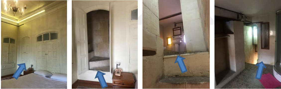
Şekil 98. Rahmi Bey Konağı oda haznadan çıkılan banyo,wc(Orijinal,2018)
