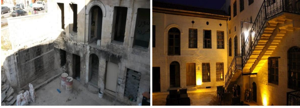
Şekil 67.Aynur Hanım Konağı restorasyon öncesi ve sonrası avlu(www.aynurhanimkonak.com)
