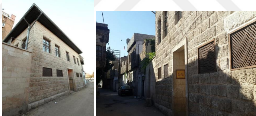
Şekil 55. Alibey Konađı 2. Konak cephe görünüm(ekentrehber.sahinbey.bel.tr,2018)
