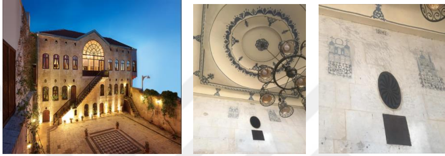
Şekil 30. Gaziantep Bey Konağı konağın tarihinin yazılı olduğu duvar ve konağın cephesi(www.gaziantepbeykonagi.com,2018)(Orijinal,2018)
