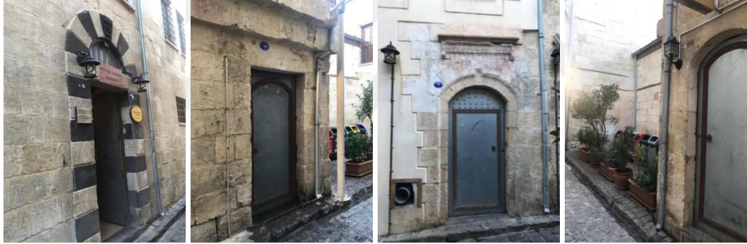
Şekil 107. Zeynep Hanım Konağı giriş kapıları (Orijinal,2018)
