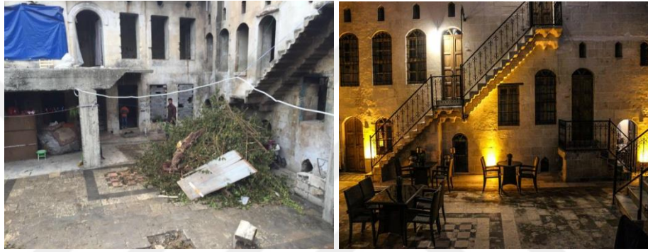
Şekil 68.Aynur Hanım Konağı restorasyon öncesi ve sonrası avlu(www.aynurhanimkonak.com)
