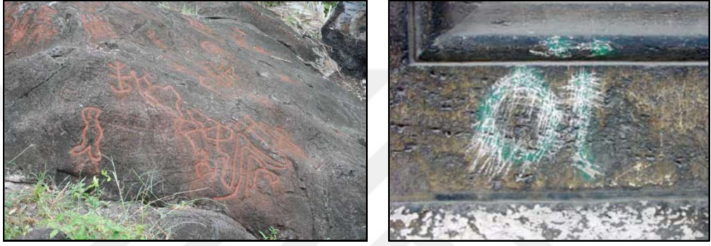
Şekil 3.24. Vandalizm sonucu görülen hasarlar
