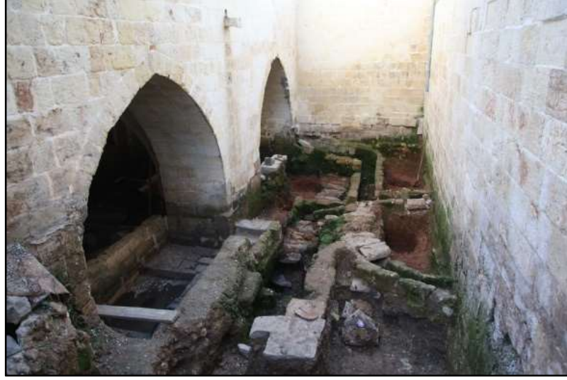
Şekil 2.25. 2015-2016 yıllarında yapılan onarımda ortaya çıkan livas ve künkler
