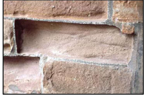
Şekil 3.2. Derinliği 5 cm'den fazla olan yüzey kaybı
