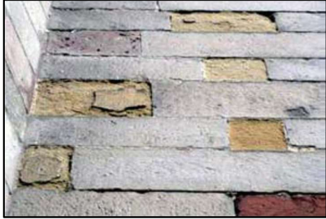
Şekil 3.1. Derinliği 5 cm'den az olan yüzey kaybı
