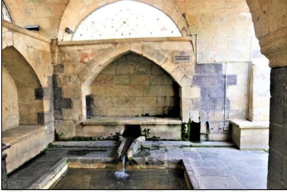
Şekil 2.30. Güneyden inilen merdivenle ulaşılan havuz
