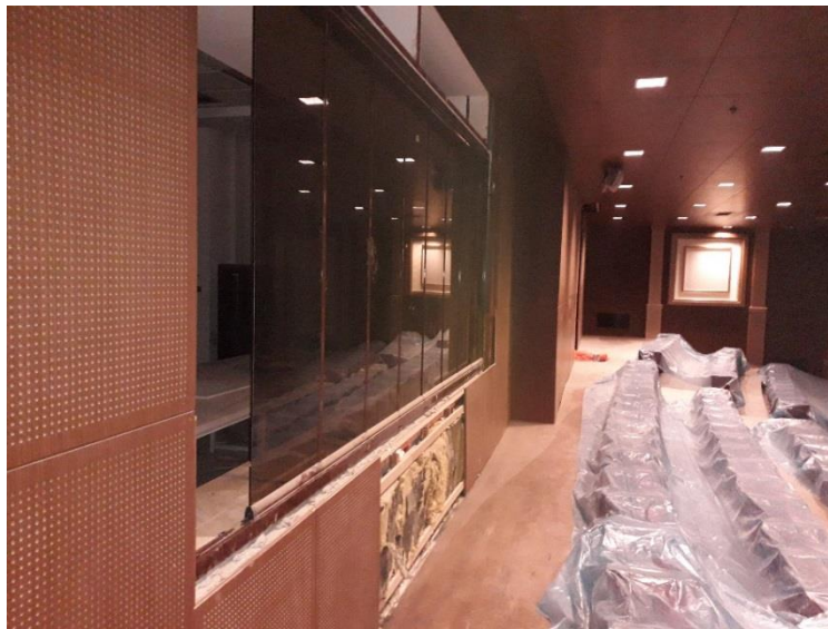
Resim 9. Arka Duvar Ahşap Uygulaması
