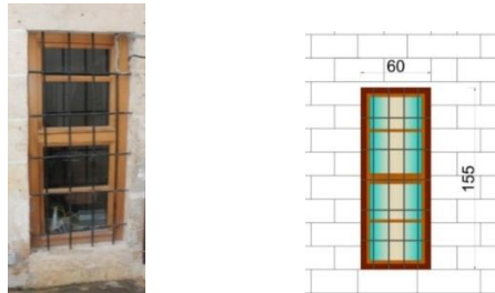
Şekil 143: Aynur Hanım Konağı Z01 Kodlu Odanın Pencere Görünüşü, 2018
