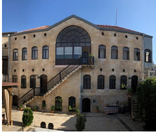
Şekil 47: Gaziantep Bey Konađı Avludan Genel Görünüm A Blok, 2018
