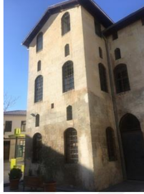
Şekil 32: Atatürk Anı Evi Avlu Cephesi Kafesli Ahşap Pencere Örneği, 2018
