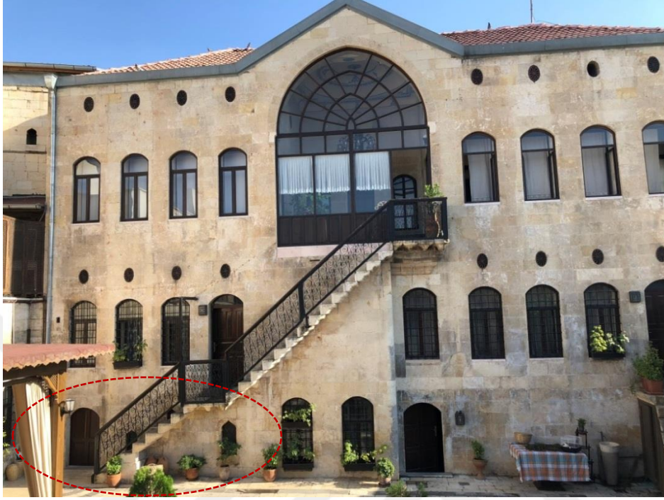
Şekil 67: Gaziantep Bey Konağı Z01 Kodlu Oda Avludan Görünüm, 2018
