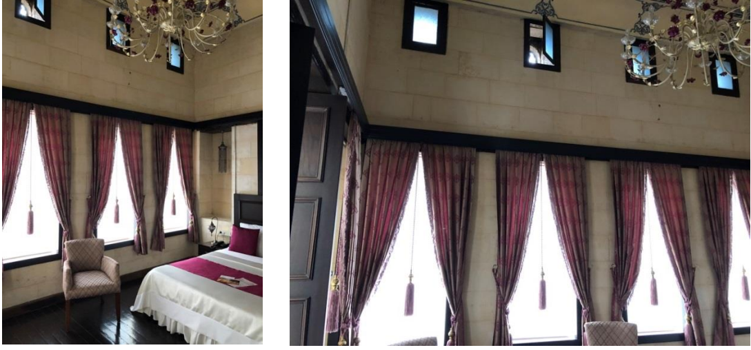
Şekil 115: Gaziantep Bey Konağı L01 Kodlu Oda Pencere Genel Görünüm, 2018
