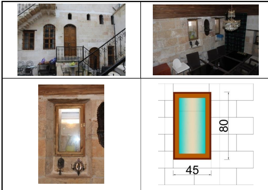
Şekil 145: Aynur Hanım Konağı Z01-1 Bodrum Katı Pencereleri, 2018
