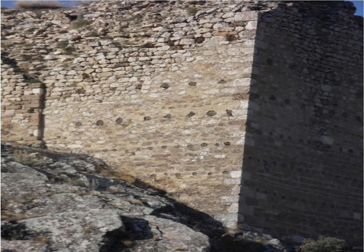
Photo 65 . Wall of DD 1-2
