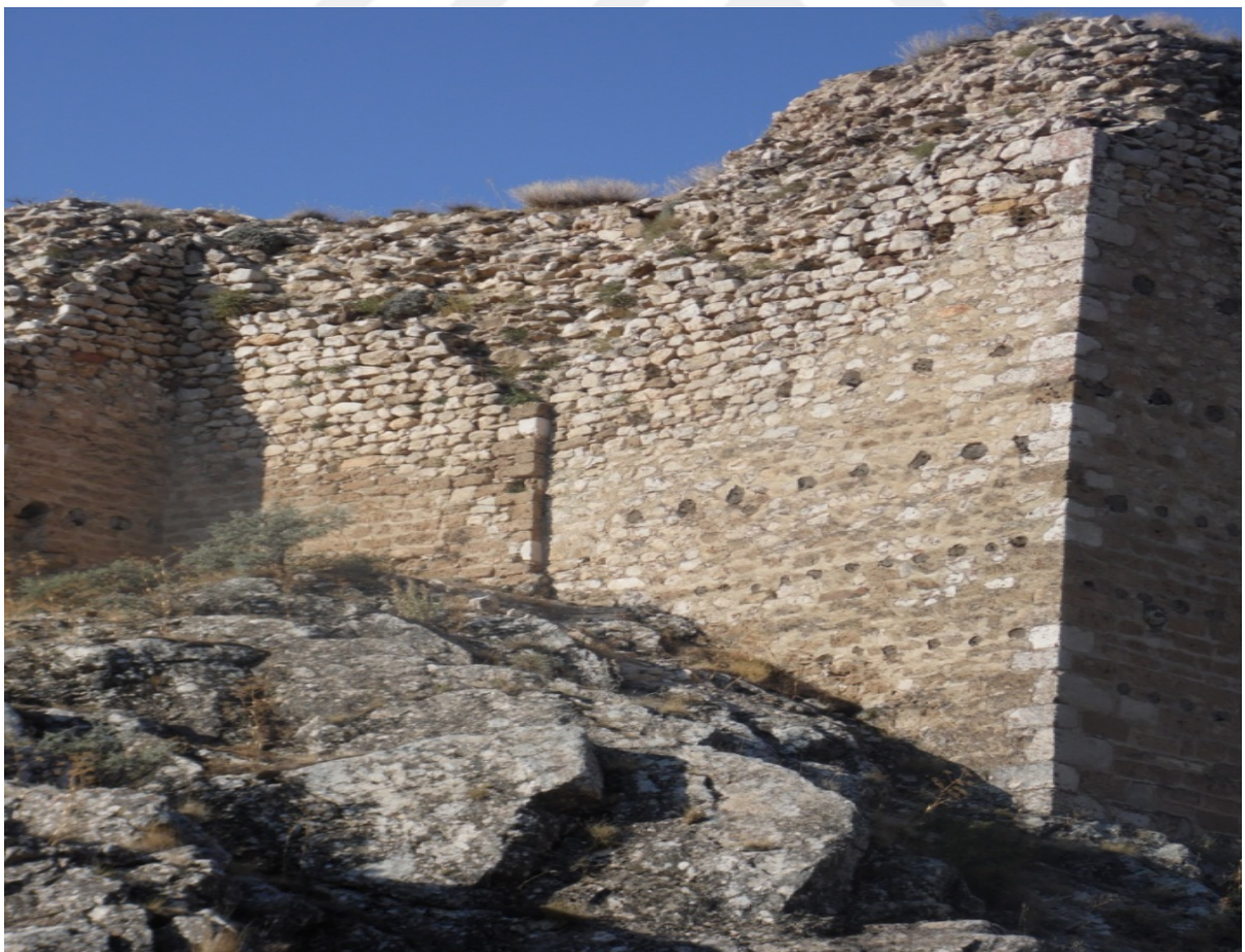
Photo 64 . Wall of DD 1-2-3
