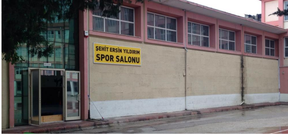
Şekil 127. Spor Salonu Kuzeybatı Cephesi, 2018
