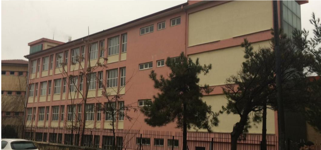
Şekil 123. Derslik B Blok Kuzeydoğu Cephe, 2018
