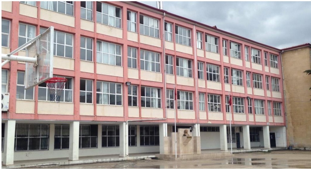
Şekil 112. Gaziantep Lisesi 3 Nolu Yapı Güneydoğu Cephesi, 2018
