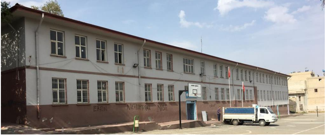
Şekil 73. Yavuzlar İlkokulu Güney Cephe, 2018
