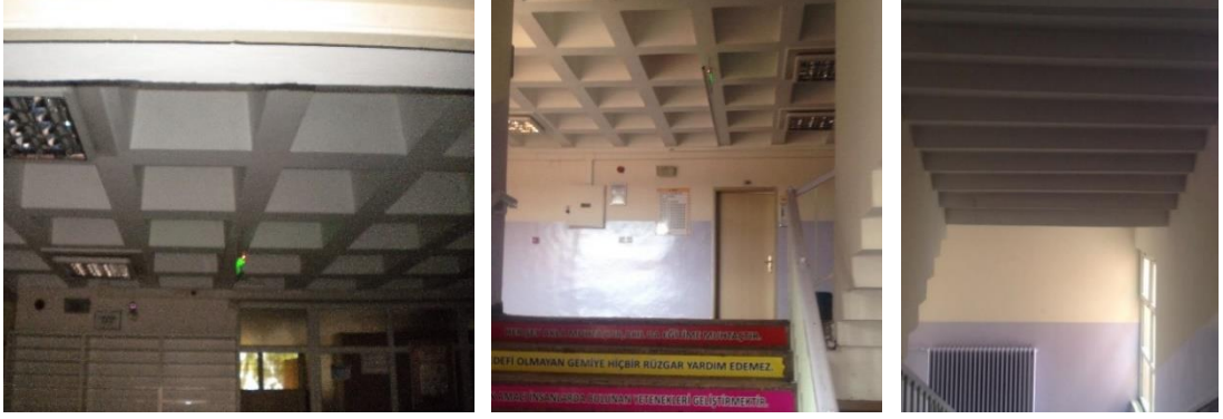
řekil 140. Pansiyon binasında bulunan kaset dđřemeler ve yapı elemanları, 2018
