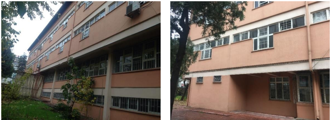
Şekil 138. Pansiyon Binası Güneydoğu Cephesi, 2018
