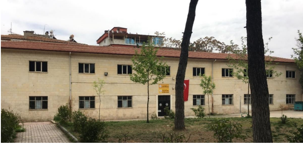
Şekil 94. Gaziantep Lisesi 1 Nolu Yapı Batı Cephe, 2018
