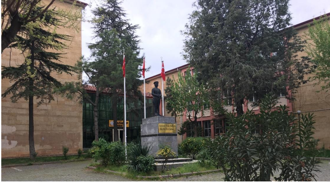
Şekil 111. Gaziantep Lisesi 2 ve 3 Nolu Yapılar Kuzeydoğu Cephesi, 2018
