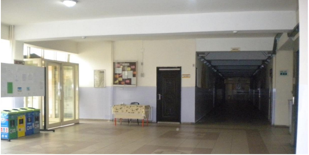
Şekil 118. Derslik B blokta bulunan rüzgârlık, 2018
