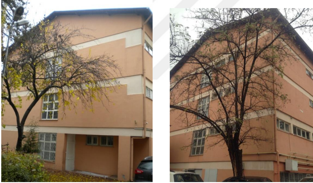
Şekil 139. Pansiyon Binası Kuzeydoğu ve Güneybatı Cepheleri, 2018
