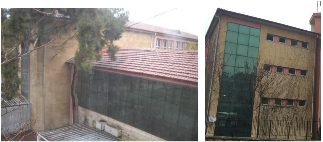
Şekil 114. Gaziantep Lisesi 2 ve 3 Nolu Yapı Güneybatı Cephesi, 2018
