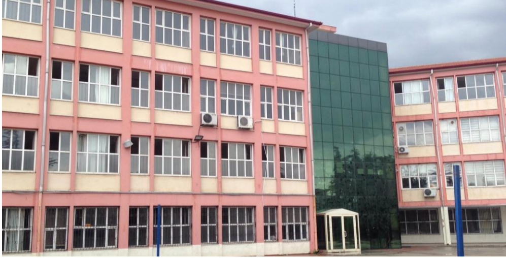
Şekil 122. Derslik B Blok Güneybatı Cephe, 2018
