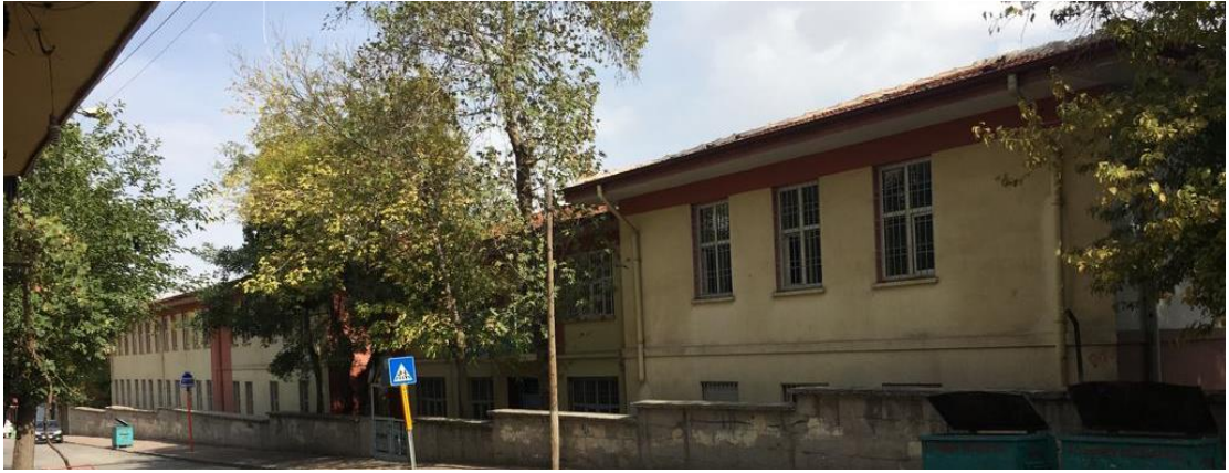
Şekil 74. Yavuzlar İlkokulu Kuzey Cephe, 2018
