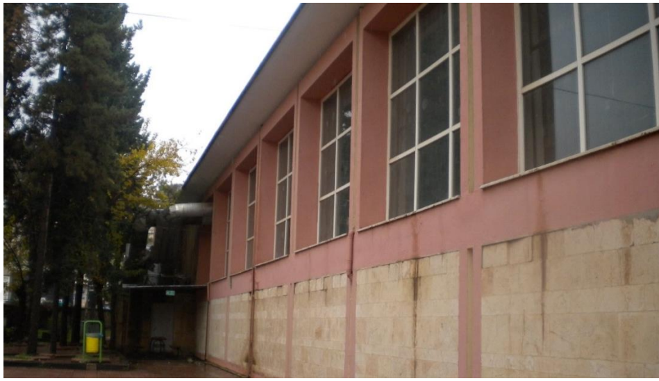
Şekil 128. Spor Salonu Güneydoğu Cephesi, 2018
