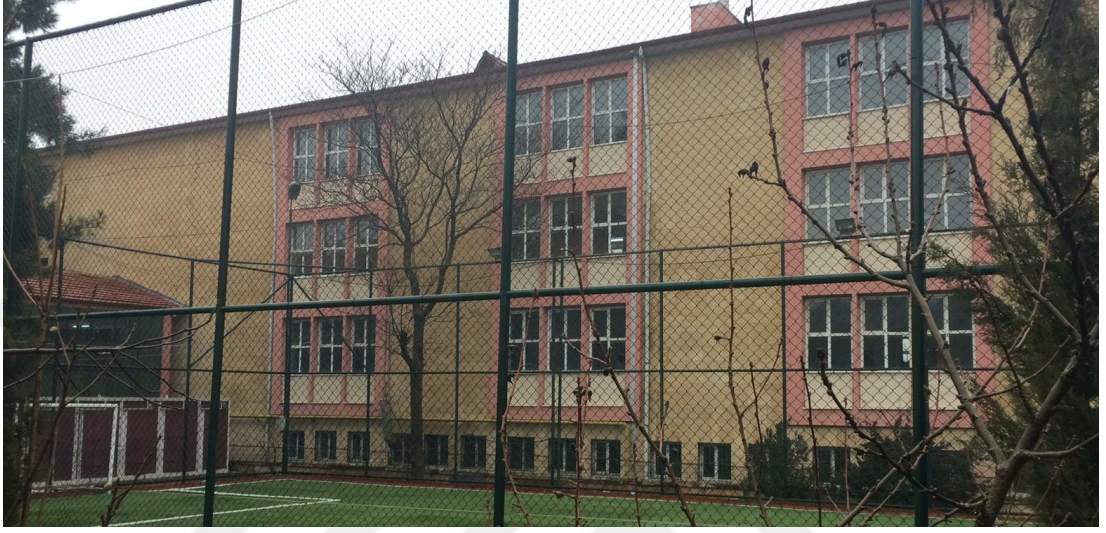
Şekil 113. Gaziantep Lisesi 3 Nolu Yapı Kuzeybatı Cephesi, 2018
