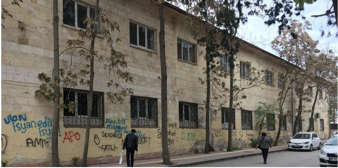
Şekil 95. Gaziantep Lisesi 1 Nolu Yapı Doğu Cephe, 2018
