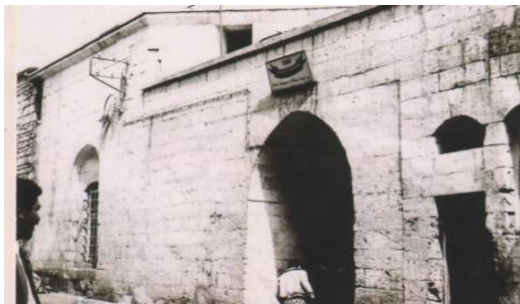
Şekil 3. 77 Velibey Hamamı giriş kapısı
