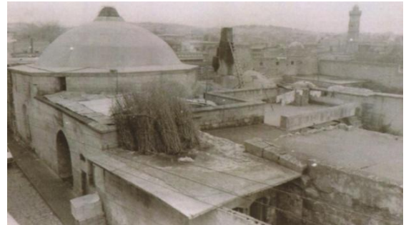
Şekil 3. 76 Hamamın güney cephesine bakış
