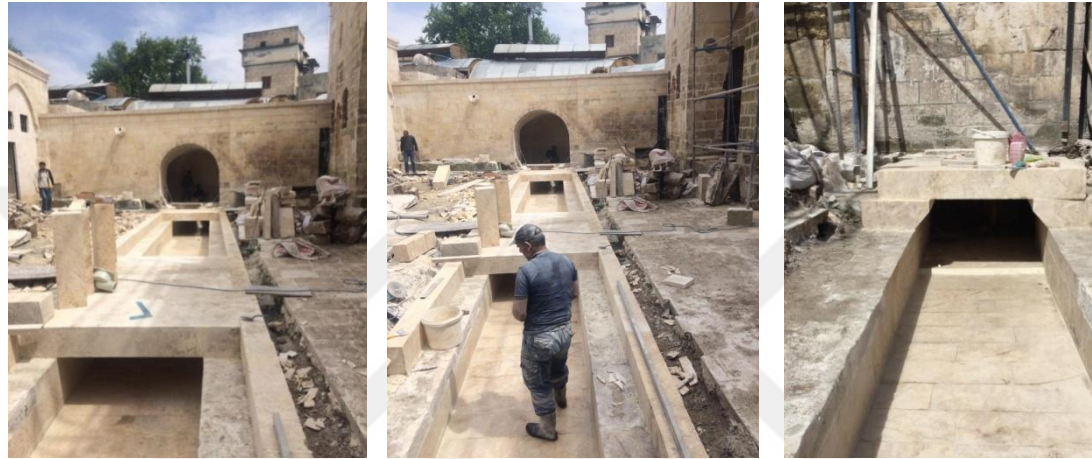
Şekil 3. 187 Pazar Cami restorasyonunda açılan Halil'ür Rahman su yolu kanalı (Orjinal, 2019)
