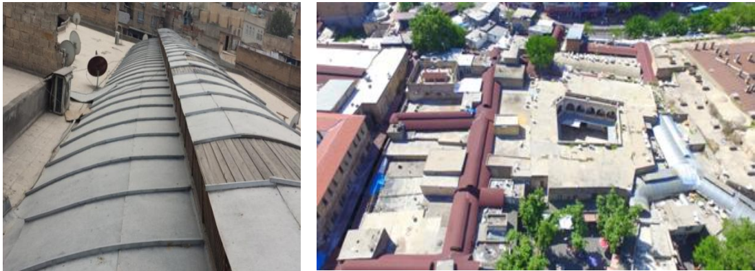
Şekil 3. 189 Hanlar Bölgesi Üst Örtü Yapım İşi çalışma öncesi-sonrası
