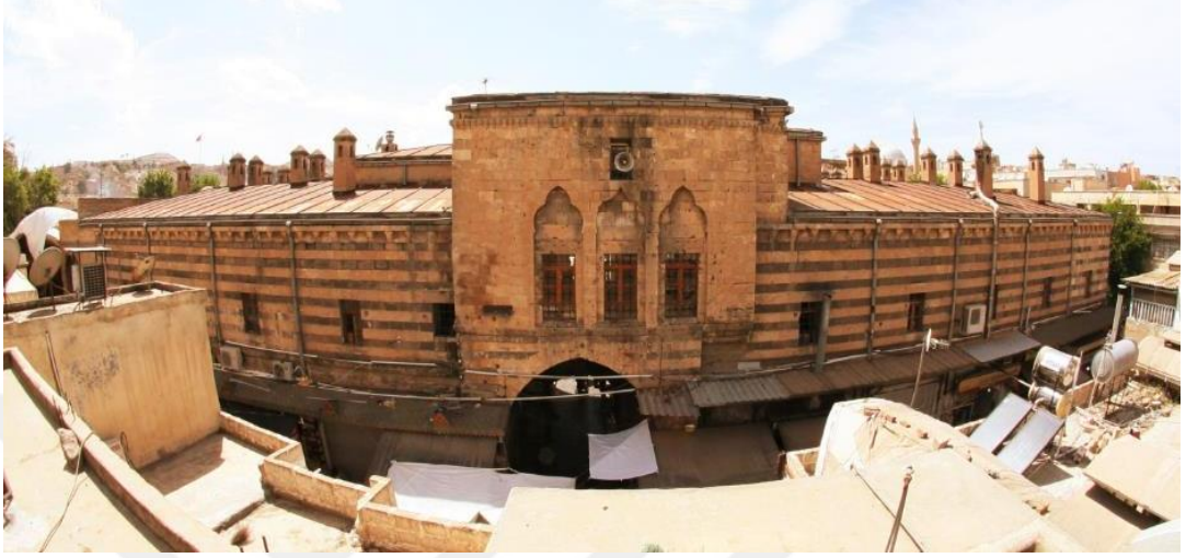
Şekil 3. 27 Gümrük Hanı-doğu giriş cephesi (Yasin Küçük)
