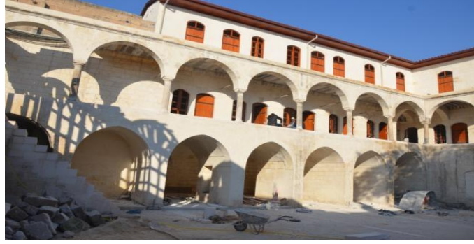
Şekil 3. 41 Develik bölümünün bulunduğu batı cephesi restorasyon sonrası
