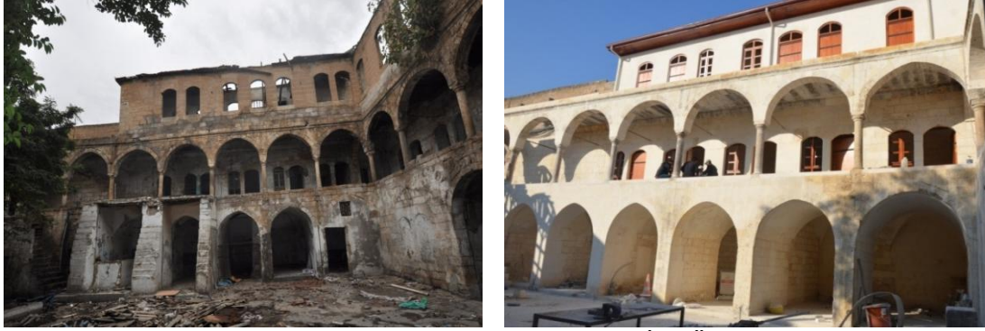
Şekil 3. 186 Barutçu Hanı Restorasyon Yapım İşİ: Öncesi ve Sonrası
