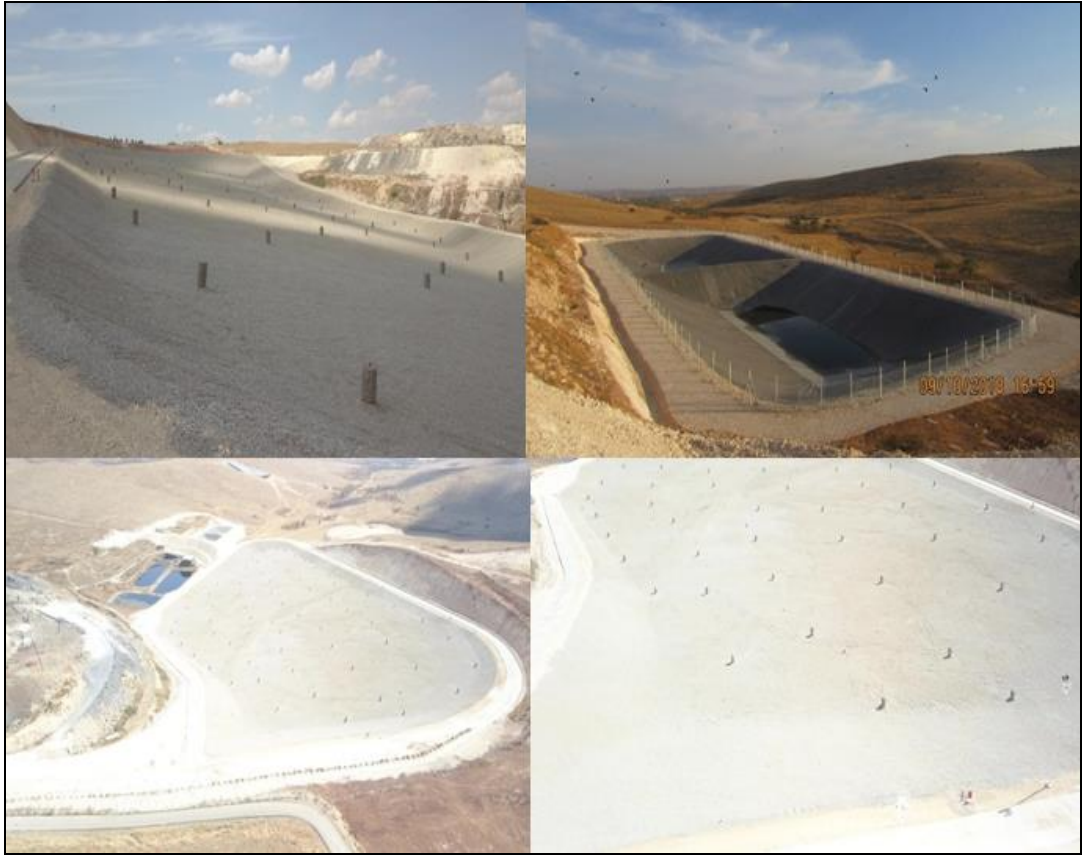
Şekil 3.1. Merkez düzenli depolama tesisi
