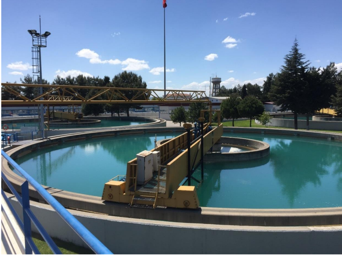
Şekil 3.5: Durultucu Ünitesi
