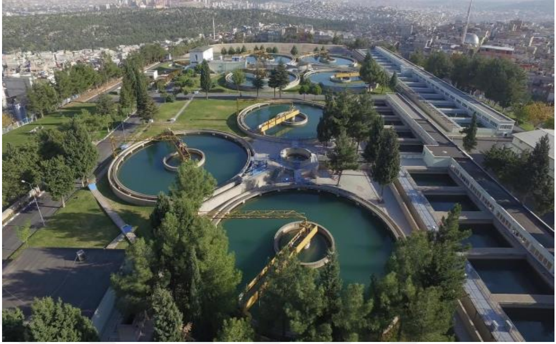
Şekil 3.3: GASKİ Hacıibaba İçme Suyu Arıtma Tesisi (GASKİ, 2019 Performans Programı)
