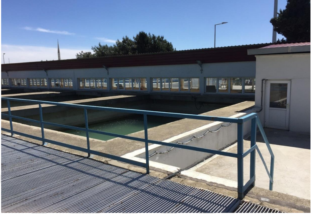
Şekil 3.7: Filtrasyon Havuzları
