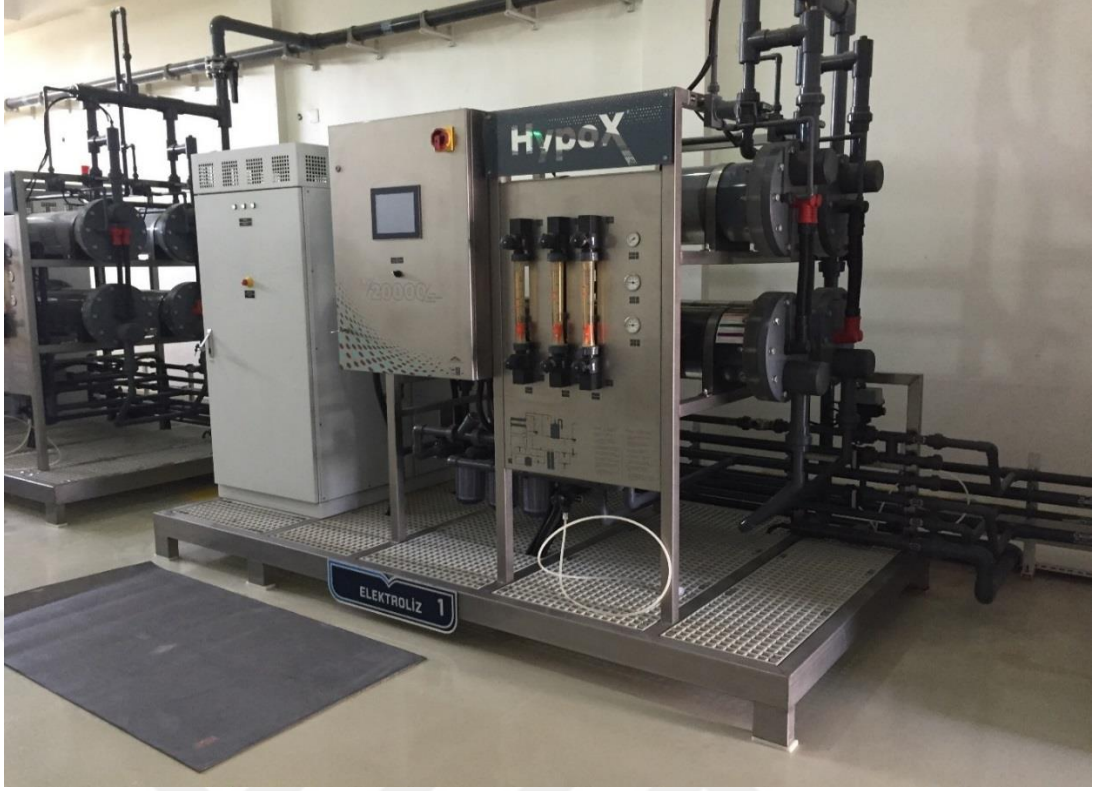
Şekil 3.9: Klor Üretiminde Elektroliz Cihazı
