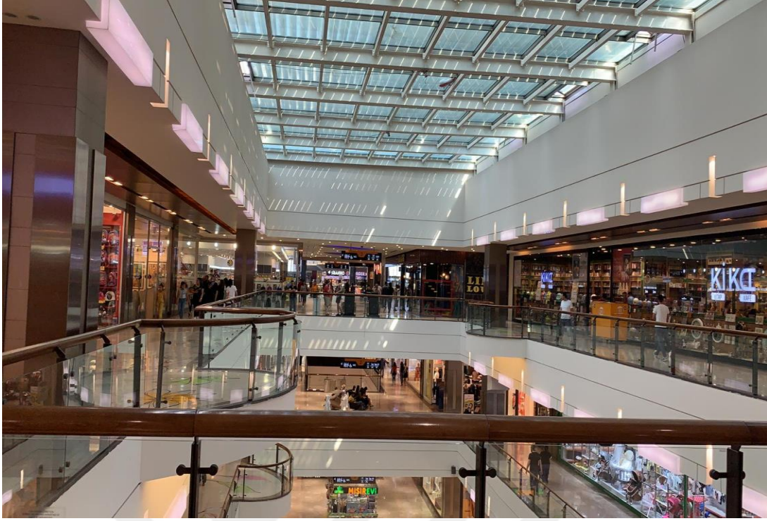
Şekil 36. Galeri Boşluğuna Uzanan Yarım Daire Zemin Formu
