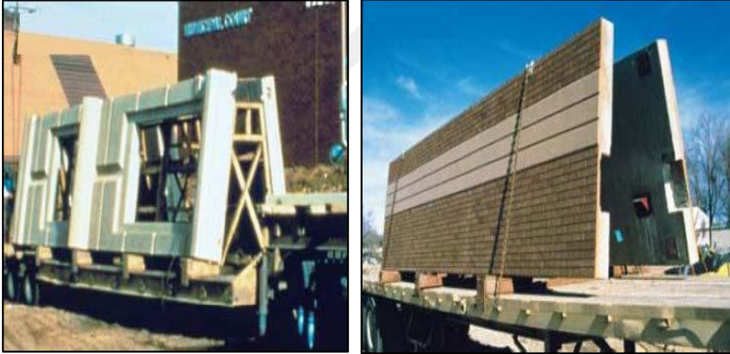
Şekil 2.25: Cephe panellerinin "A" çerçeveli taşıma aracına yerleştirilmesi (Altınay, 2011).
