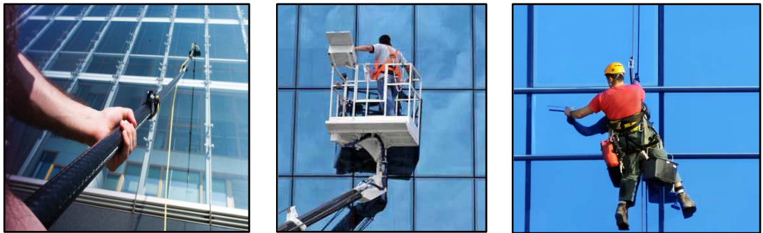
Şekil 3.9: Uzun çubuklu fırçalar, Vinç yardımı ve Çatıdan sarkıtılan halat yardımı ile temizlik.
