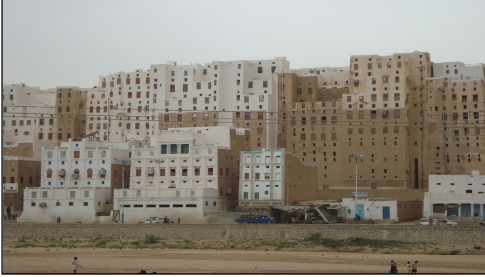
Şekil 2.9: Yemen'in Şibam Şehrindeki dünyanın en yüksek kerpiç evleri (URL-06). Doğu Anadolu'da kışların çok sert geçtiği dağlık bir bölgelerde özellikle kerpiç ve taş malzemenin hâkimiyeti görülür. 70-80 cm. kalınlıktaki kerpiç beden duvarları içinde, az sayıda pencere ve kapılar, küçük açıklıklar halindedir ve duvar yüzeylerinde doluluk hâkimdir.
