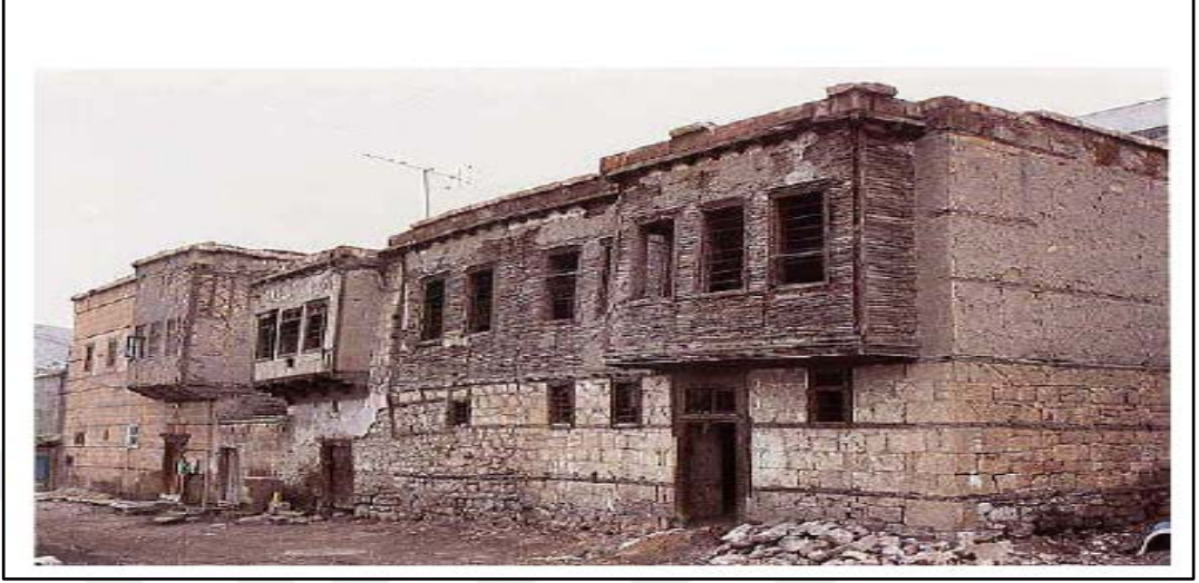
Şekil 2.28: Taş ve Tuğla arasında kullanılan Ahşap lento, hatıl örnekleri (Arun, 2005).
