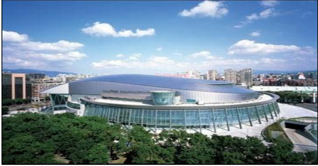
Şekil 2.45: Titanyum kompozit dış cephe malzemesi kullanımı (URL-18).
