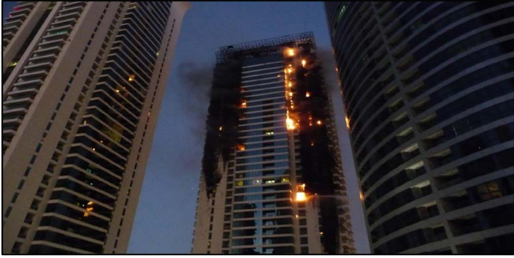
Şekil 3.6: Dubai Tamweel Tower yangın görüntüsü 2012 (Kılıç, 2012).
