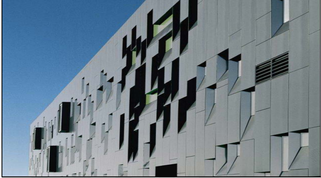
Şekil 2.44: Çinko kompozit dış cephe malzemesi kullanımı (URL-17).
