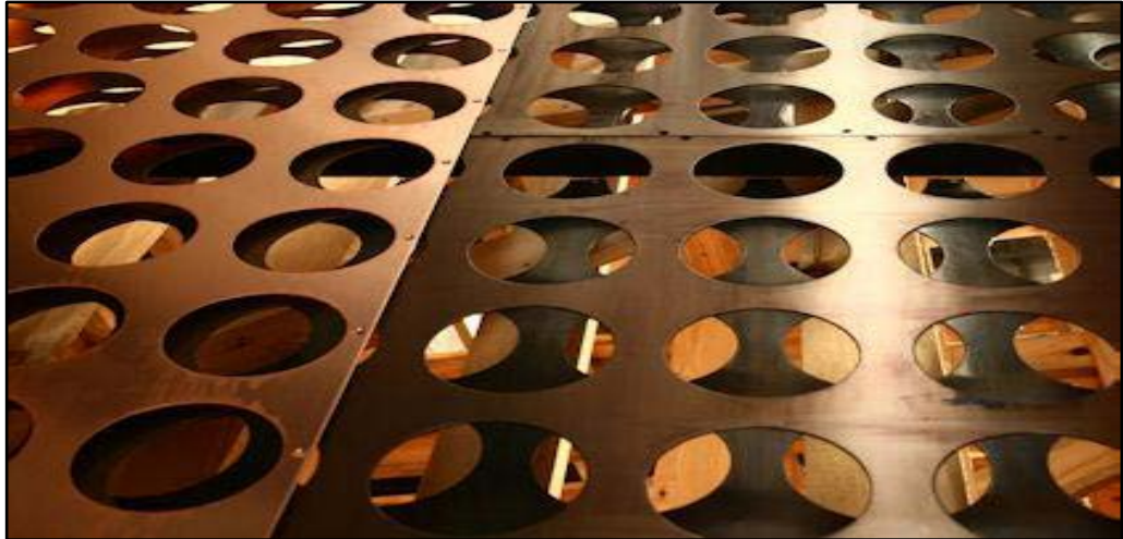
Şekil 2.46: Bakır kompozit dış cephe malzemesi kullanımı (URL-19).
