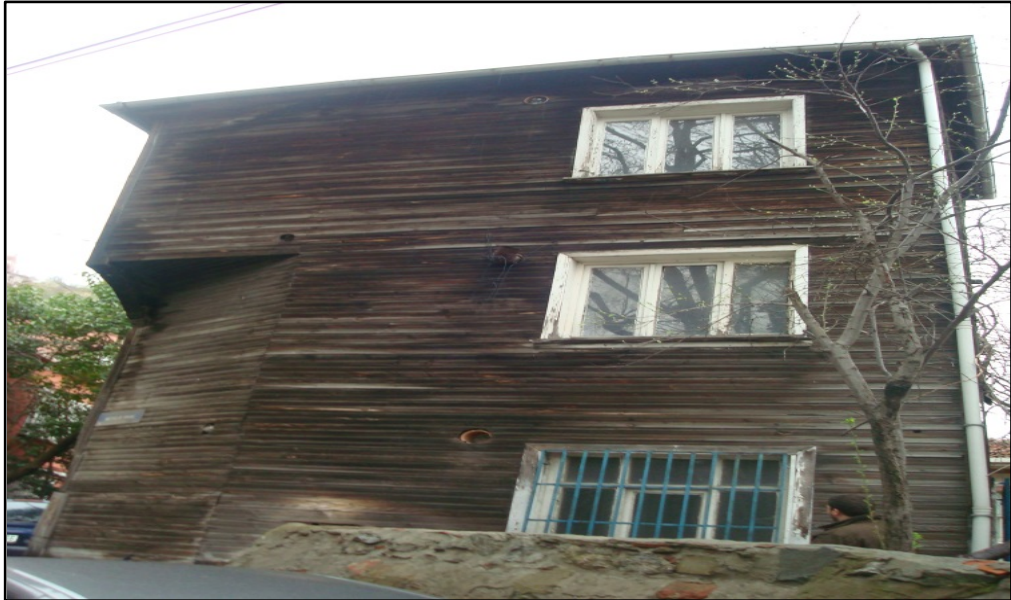
Şekil 2.17: Ahşap karkas sistemde yalı baskı cephe kaplaması Arnavutköy, İstanbul (Orbay, 2019).
