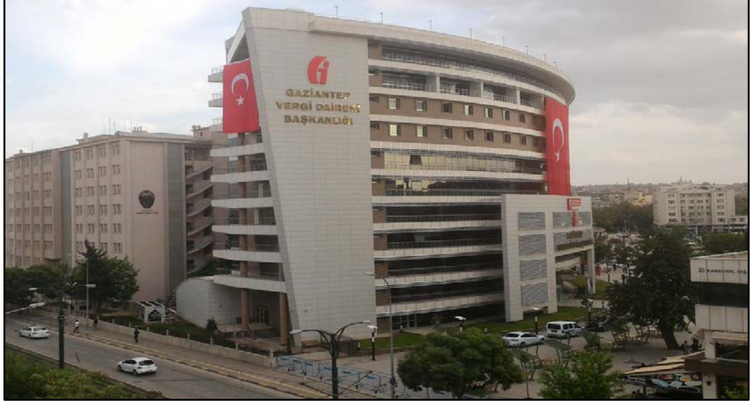
Şekil 2.7: Taş kaplama giydirme cephelere örnek (Gaziantep Vergi Dairesi Hizmet Binası), (Orbay, 2019).
