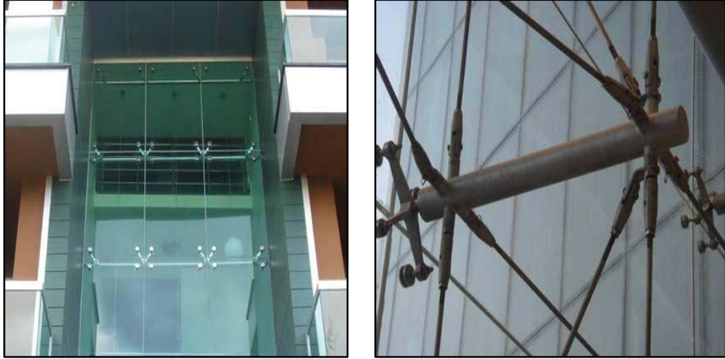
Şekil 2.37: Transparan Giydirme Cephe Örneği ve bağlantı elemanı (URL-13).
