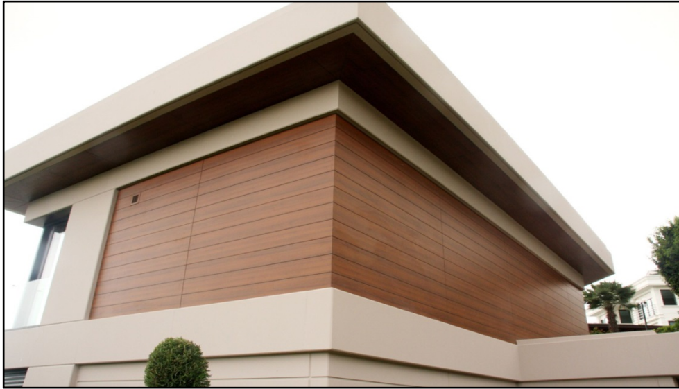
Şekil 2.20: Kompakt lamine cephe kaplama örneği
