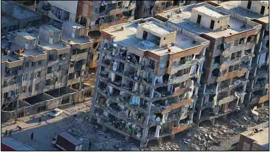
Şekil 4.2: 1999 Gölcük depreminde dış duvarları hasar görmüş yapılar (URL- 20).
