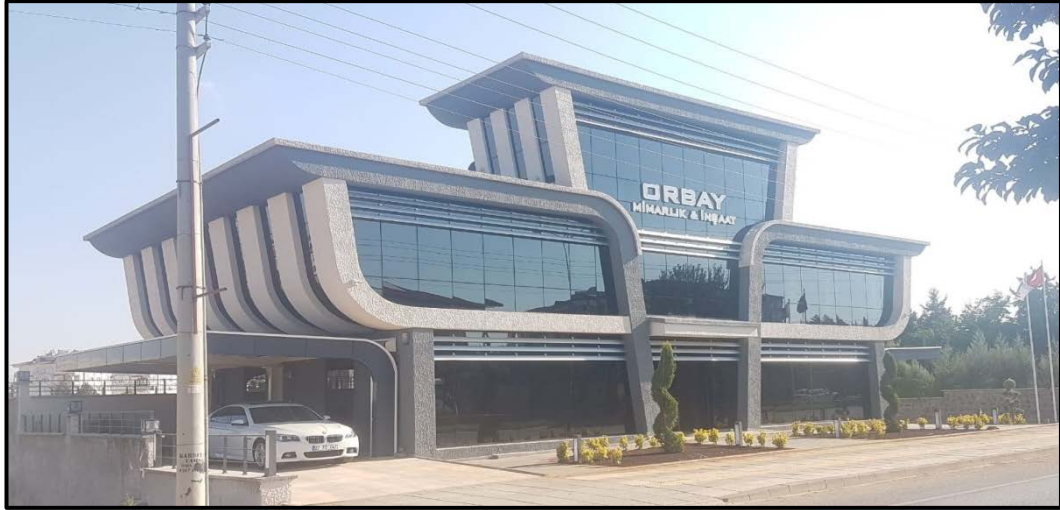
Şekil 3.4: Doğu cephesinde güneş kırıcıların kullanıldığı bina örneği (Orbay, 2019).
