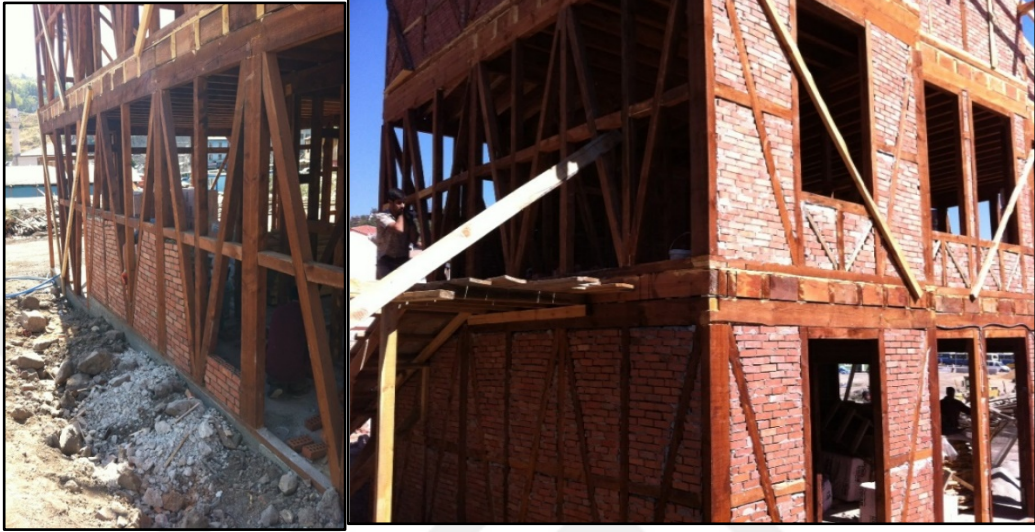
Şekil 2.16: Tuğla ile doldurulmuş ahşap karkas sistem (URL-08).
