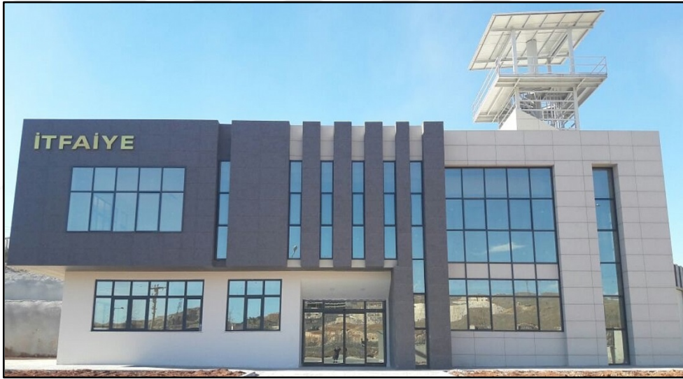
Şekil 2.31: Kapaklı giydirme cephe uygulamasına örnek (Gaziantep Organize sanayi İtfaiye Binası), (Orbay, 2019).
