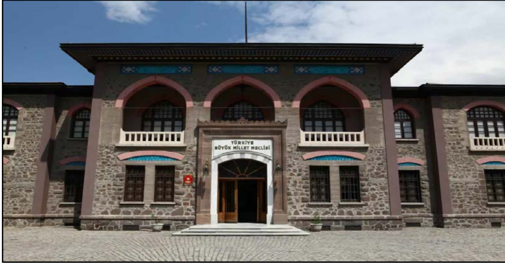
Şekil 2.4: II. TBMM Binası (1923–24) Mimar Vedat Tek (URL-02).
