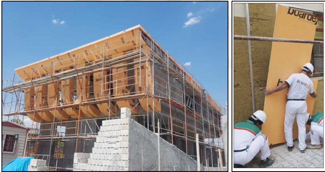
Şekil 2.39: Panel duvar sistem uygulamasına örnekler (Orbay, 2019).
