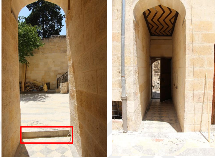
Şekil 112. Hasan Süzer Etnografya Müzesi Girişinde Karşılaşılan Eşik Sorunu(Orijinal 2018)
