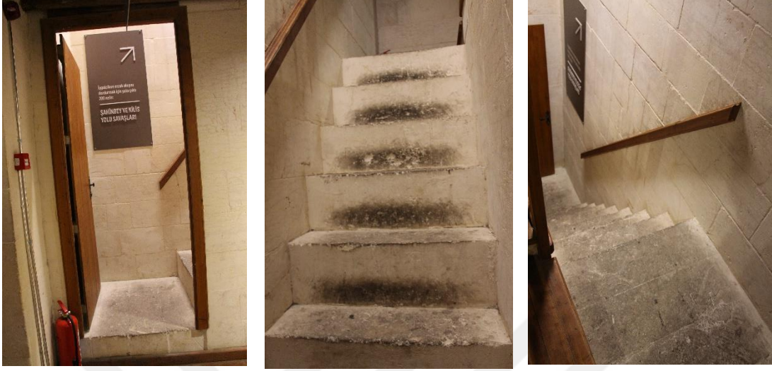
Şekil 164. Milli Mücadele Müzesi Birinci Yapı Çatı Katına Çıkan Merdiven(Orijinal 2018)
