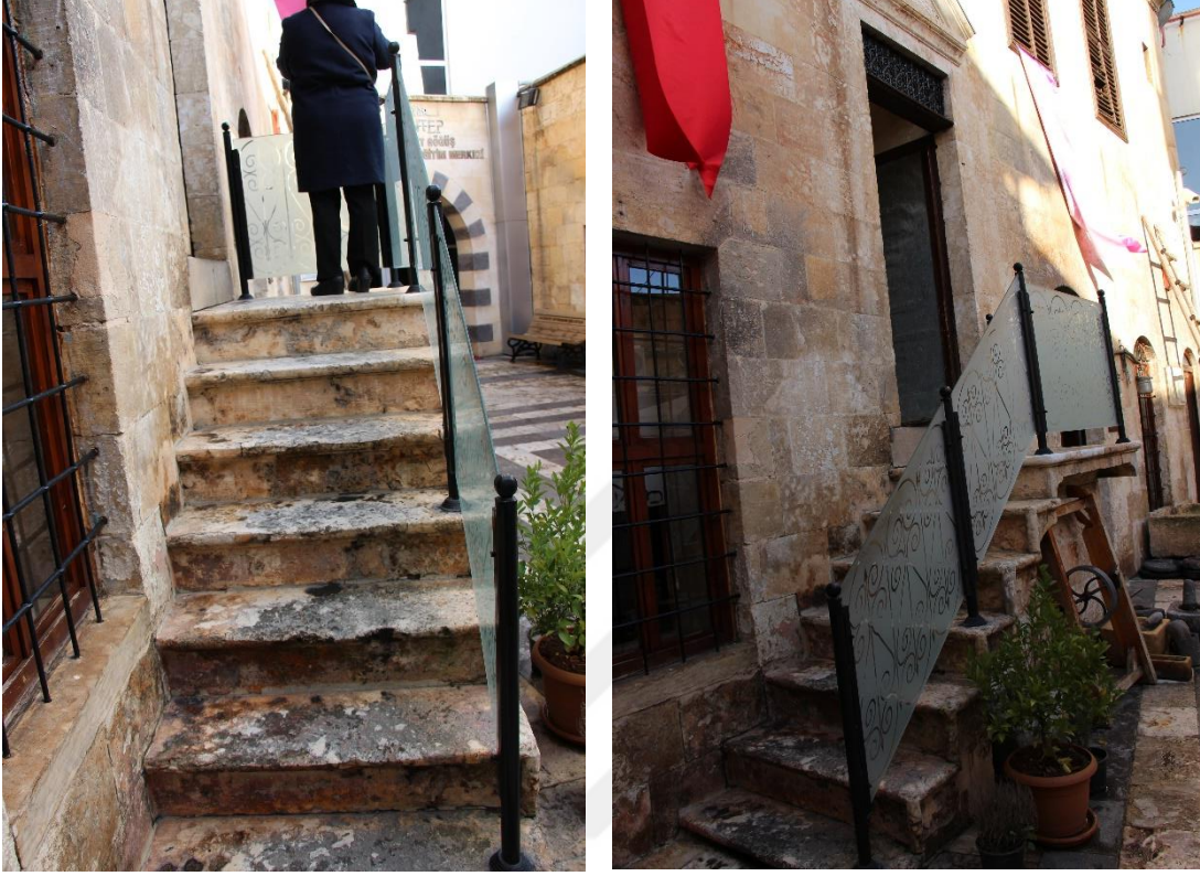
Şekil 100. Emine Göğüş Mutfak Müzesi Birinci Kata Çıkan Avlu Merdiveni(Orijinal 2018)
