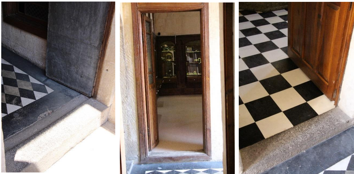
Şekil 87. 1.Kat Soldan Sağa Avlu Merdiveni Sahanlık Eşiği, Oda Beş ve Altı Eşik Sorunu(Orijinal 2018)
