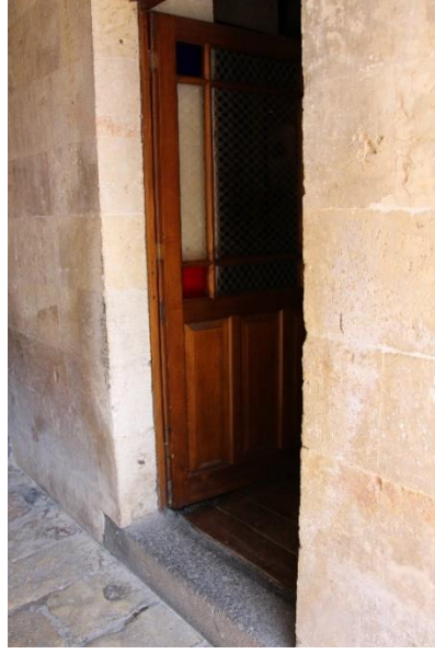
Şekil 85 .Oyun Oyuncak Müzesi Zemin kat Girişi Kapı Eşik Sorunu (Orijinal 2018)
