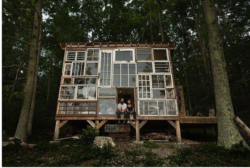
Şekil 4.11: Eski pencerelerden bir barınağın dış cephesi (Arkitera, 2017)
