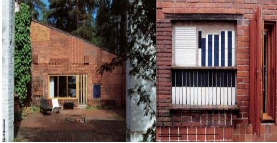
Şekil 3.62: Muuratsalo Deneysel Konutu'nun dış cephe görünümü (Kurnalı&Koca, 2018:311)
