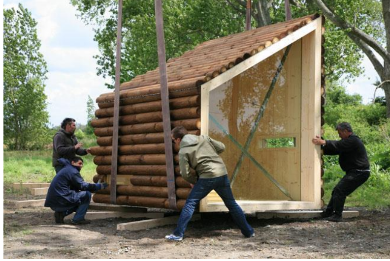
Şekil 3.68: Flake Evi, The Flake House'un taşınması (Olgga Architects,2009)
