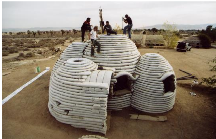
Şekil 4.9: Kum torbası barınağı yapım aşaması (Balkaza, 2008)
