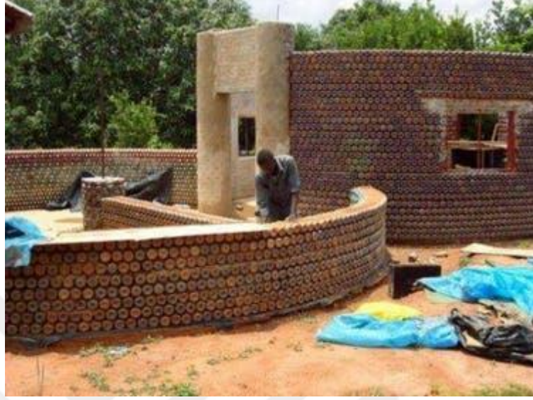
Şekil 4.2: Plastic Bottle House.Kumla dolu plastik şişelerden ev. (Guarino, 2015)
