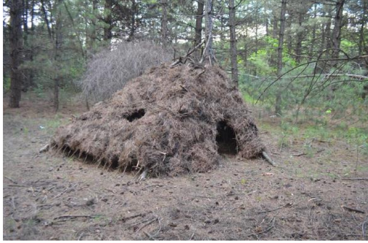
Şekil 3.23: Dallardan çam iğnelerinden barınak (Öner, 2018;29)
