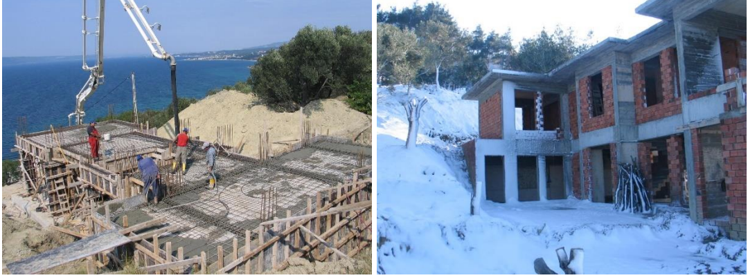
Şekil 3.39. “A” Konutu İnşaat Görünümleri
