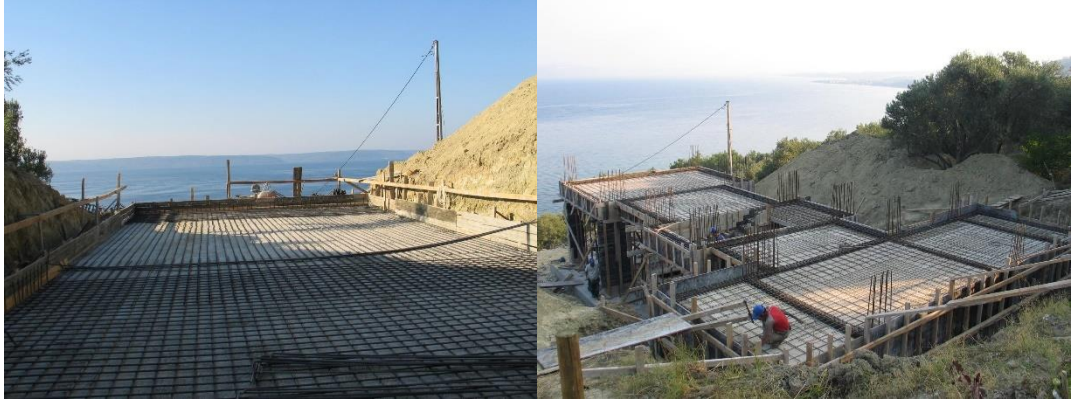
Şekil 3.38. “A” Konutu Temel Görünümleri
