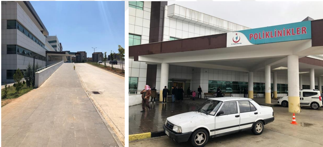
Şekil 6.5: Abdülkadir Yüksel Devlet Hastanesi Poliklinik Binası Giriş Yolu ve Bina Girişi (Mermer,2019)
