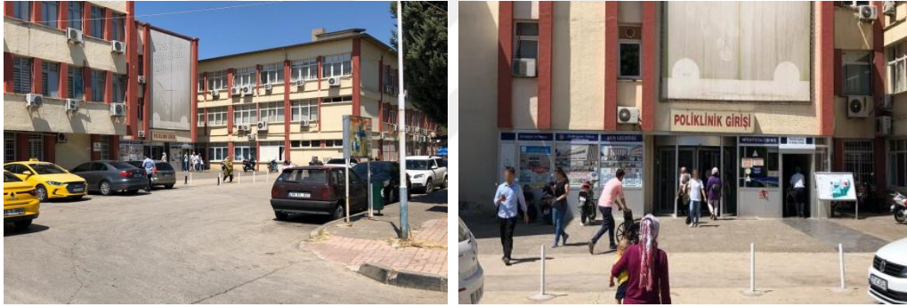
Şekil 6.3: 25 Aralık Devlet Hastanesi Poliklinik Binası Giriş Yolu ve Bina Girişi (Mermer, 2019)
