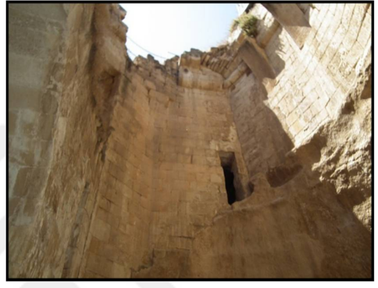
Şekil 4.32. Sarnıç İç Duvarları (Arkeolog Ali Korkmaz)
