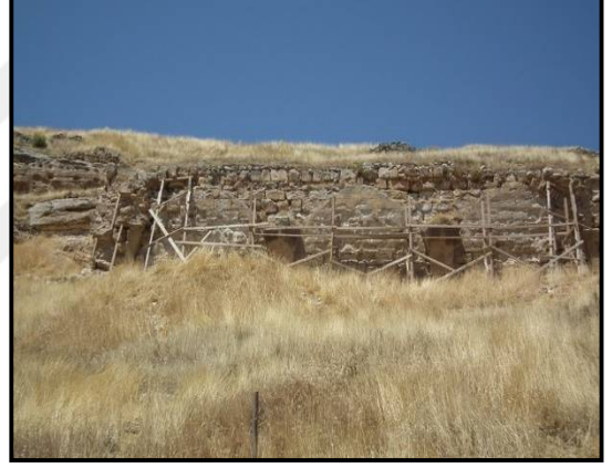
Şekil 4.30. Dink Damı Dış Cephe (N, Demirtaş)
