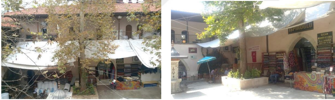
Şekil 4.40. Avlu Kuzey Cephe (solda), Avlu Zemin Kat Kuzey Cephe (sağda), 2019.
