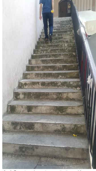
Şekil 4.18. Avlu Ana Merdiven, 2019.
