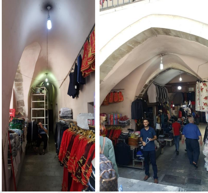
Şekil 4.13. Avlu Batı Revakı Beşik Tonoz (Solda), Çapraz Tonoz (Sağda), 2019.
