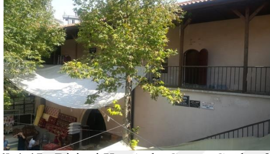
Şekil 4.45. Birinci Kat Avlu Güney Cephe, 2019.
