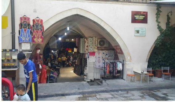
Şekil 4.38. Kesme Taş Sivri Kemer. (Işık, M. 2001)
