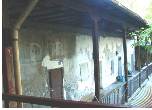
Şekil 4.37. Ahşap Dikmeler ve Çatı. (Işık, M. 2001)
