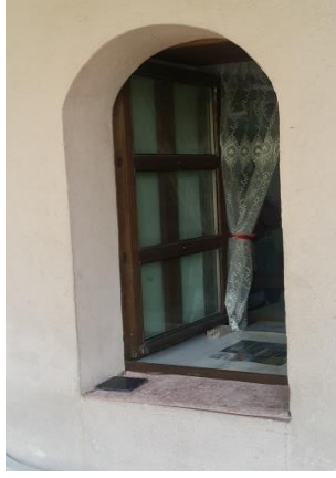
Şekil 4.35. 1-20 Basık Kemerli Pencere, 2019.
