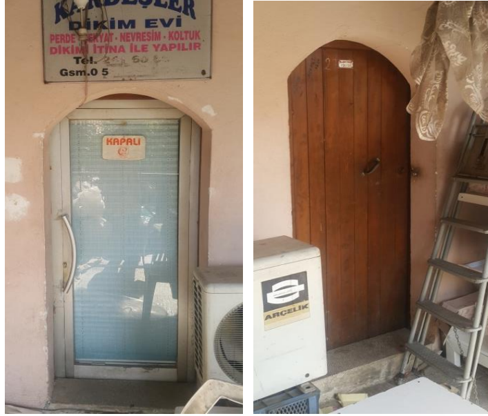
Şekil 4.31. 1-02 Metal Kapı (Solda), 1-01 Ahşap Kapı (Sağda), 2019.
