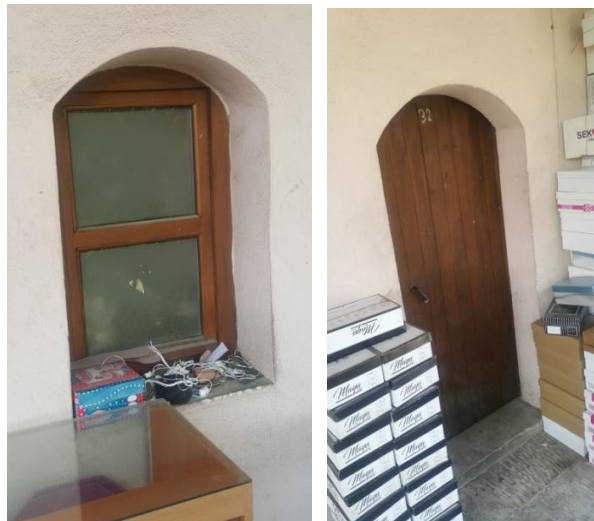
Şekil 4.28. Basık Kemerli Pencere(solda), Basık Kemerli Ahşap Kapı (sağda), 2019.
