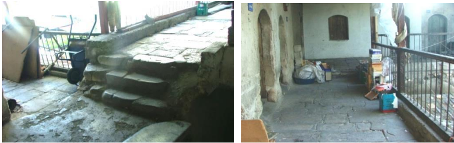
Şekil 3.27. Birinci Kat Güneydoğu Merdiven (Solda), Kuzeydoğu Merdiven (Sağda). (Işık, M. 2001)
