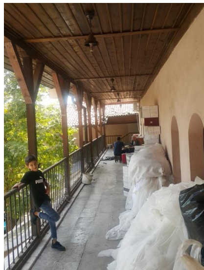
Şekil 4.25. Birinci Kat Kuzey Revakı, 2019.
