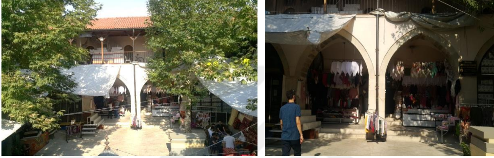
Şekil 4.42. Avlu Doğu Cephe(solda), Zemin Kat Avlu Doğu Giriş, (sağda), 2019.
