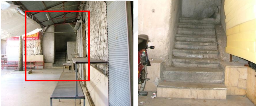
Şekil 3.23. Güneydoğu Bölümü Merdiven Girişi (Solda), Merdiven (Sağda). (Işık, M. 2001)
