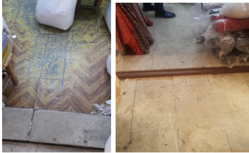
Şekil 4.7. Z-01 PVC Zemin Kaplama (Solda), Z-16 Traverten Zemin Kaplama (Sağda), 2019.
