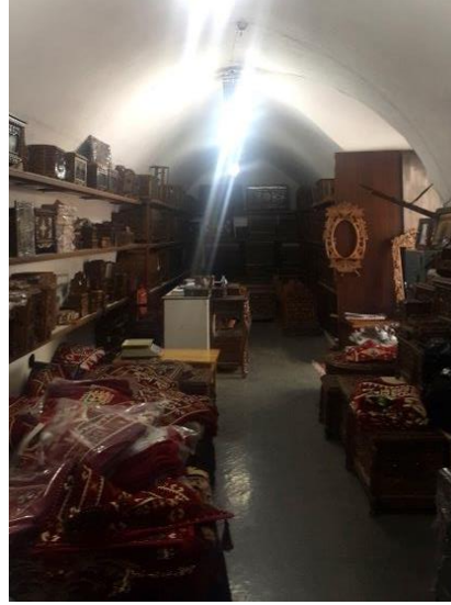
Şekil 4.16. Z-14 Dükkânı Sivri Tonoz.
