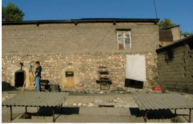
Şekil 3.28. Yükseltilmiş Dış Duvar. (Işık, M. 2001)
