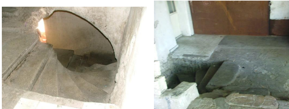
Şekil 3.24. Güneydoğu Bölümü Merdiven Birinci Kat Girişi. (Işık, M. 2001)
