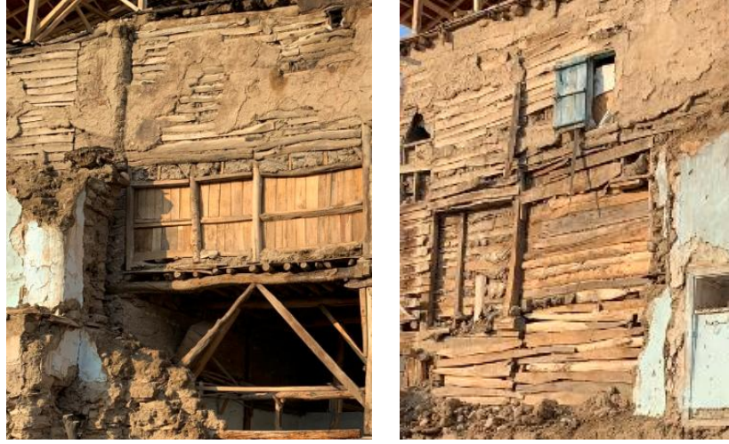
Şekil 3.18: Tarihi Yeşilyurt Evleri taş, kerpiç, ahşap duvar kesiti örneği (2019)
