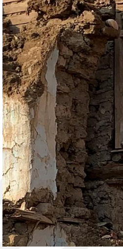
Şekil 3.20: Tarihi Yeşilyurt Evleri anaç duvar kesiti örneği (2019)
