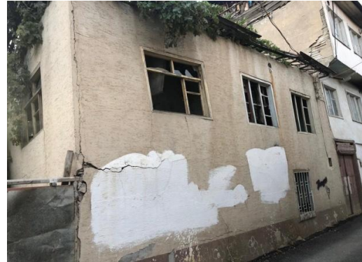
Şekil 4.18: Malatya deprem haritası (D.A.D.L.Ş.M), Taze Değirmen Çıkmazı sokağında bulunan kargır yapının depremden aldığı hasar örneği (2019)
