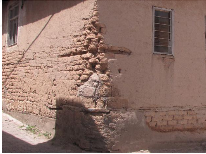
Şekil 3.21: Tarihi Yeşilyurt Evleri kerpiç duvar örneği (2019)
