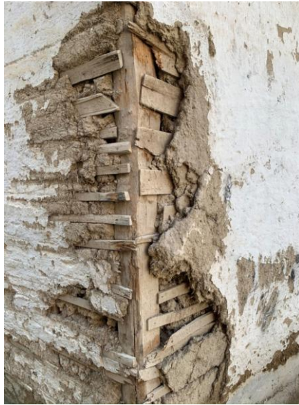
Şekil 3.19: Tarihi Yeşilyurt Evleri hımış duvar örneği (2019)
