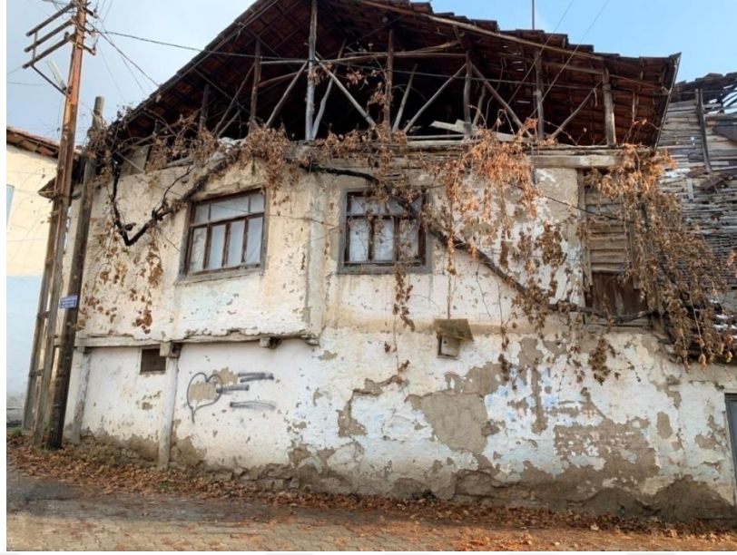
Şekil 4.21: Çatı açıklığı ve saçağı örneği (2019)
