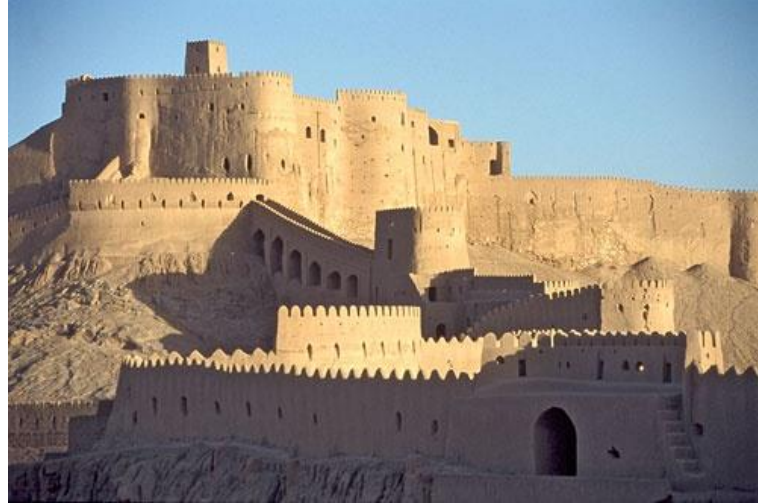
Şekil 2.8. Dünyadaki en büyük kerpiç yapı (Arg-é Bam) ( http://www.castlesandmanorhouses.com/photos-middleeast.htm )
