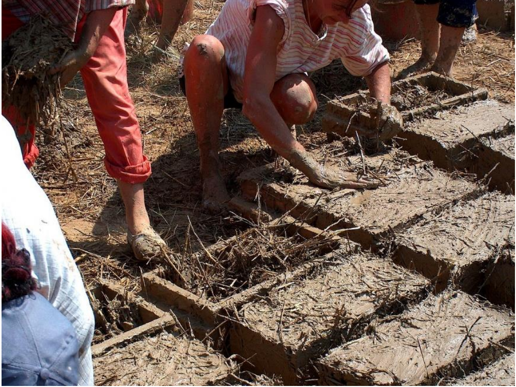
Şekil 2.21. Kerpiç Kalıplama İşlemi
