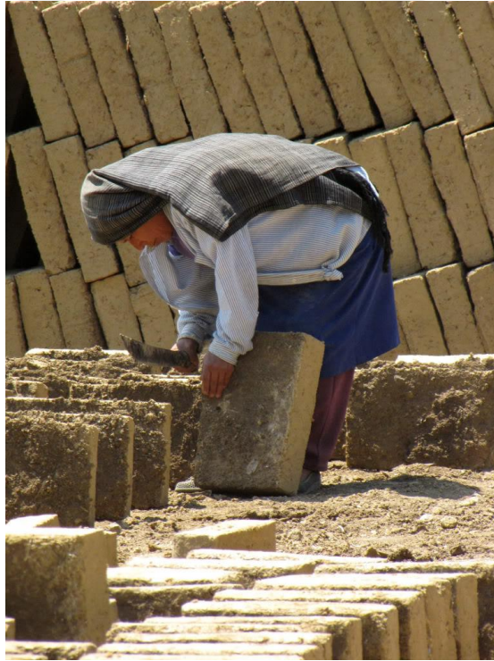
Şekil 2.23. Kerpiç blokların kurutma ve depolanması
