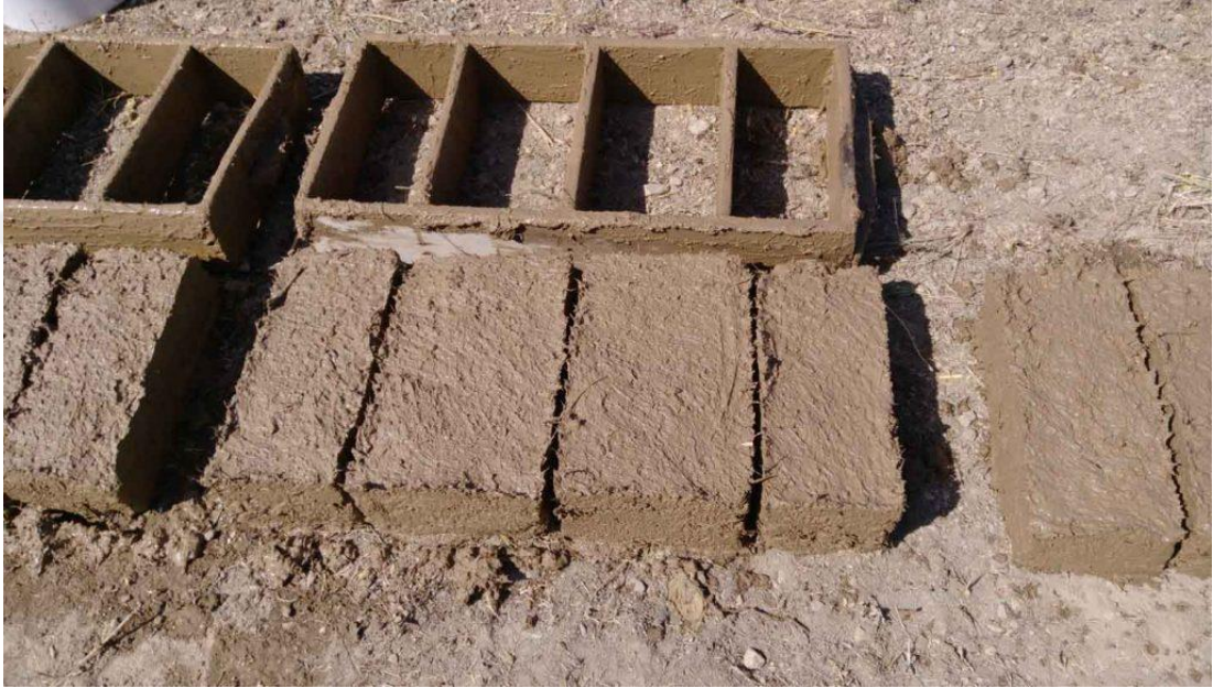
Şekil 3.9. Kerpiç blokların döküm işlemi ( https://www.e-villaproje.com/e-villa-projeleri/kerpic-evler-kerpic-ev-uretimi-geleneksel-evler-10-1024x583.jpg )
