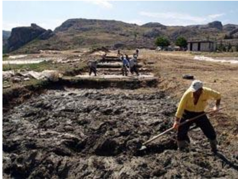
Şekil 2.20. Kerpiç harcındaki samanın önce bazı aletlerle karıştırılıp daha sonra ayakla çiğnenmesi
