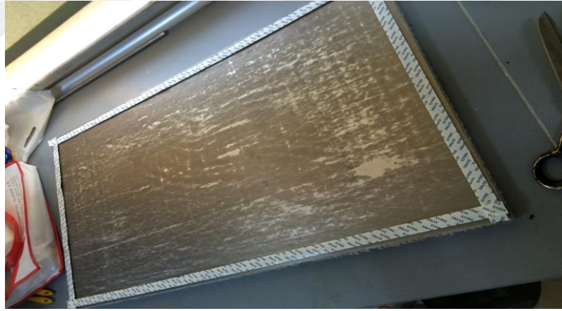
Şekil 3.13 : Kalıp çevresine sızdırmazlık bandı uygulaması
