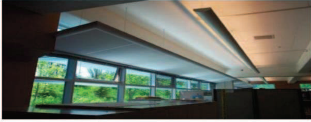
Şekil 3.8: Işık rafı uygulaması örneği [Anonim].
