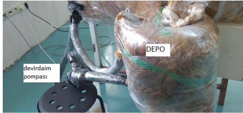
Şekil 3.17 : Dış üniteden geçen hava akımının soğutulması için kurulan sistem.
