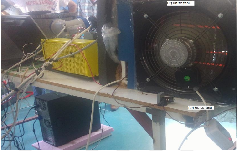
Şekil 3.16 : Dış ünite elektrikli ısıtıcı, fan hız sürücü ve ısıtıcı dimmer devresinin görünümü.
