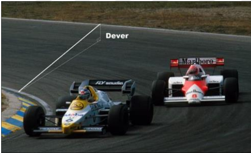
Şekil 2.5: Dever uygulaması yapılmış bir kurp [18]
