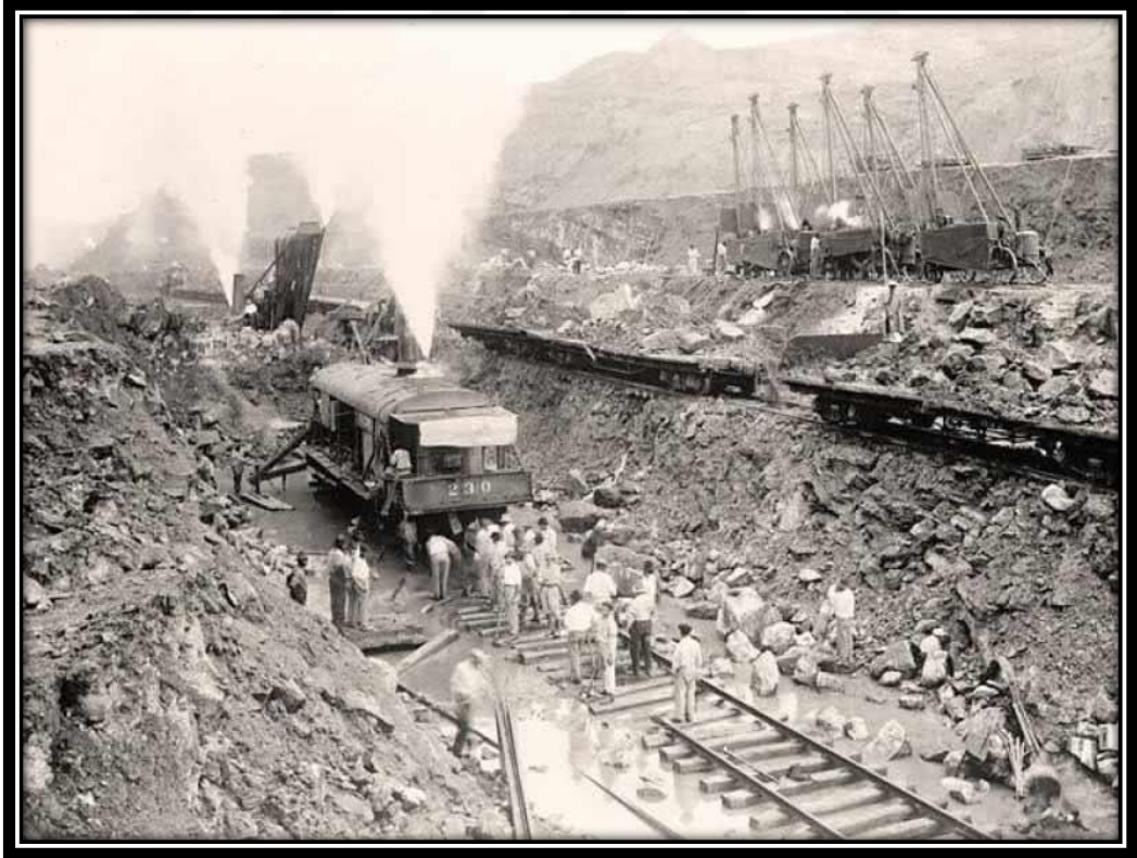
Şekil 2.9: Panama Kanalı İnşaatı [37]
