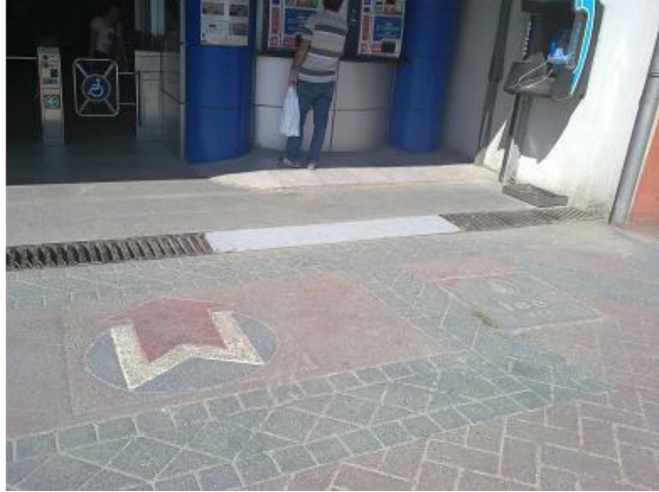
Fotoğraf 13: Metro İstasyonlarında Mazgal Aralıklarının Daraltılması Uygulaması
