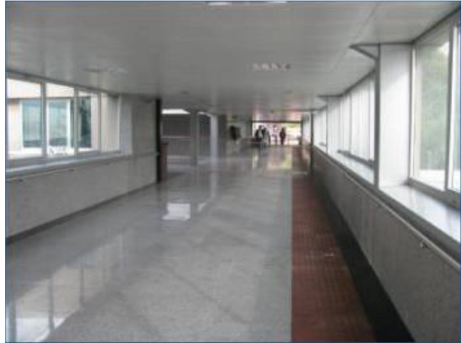
Fotoğraf 12: M1 Hattında Kartaltepe İstasyonuna Yapılan Yönlendirme Uygulaması
