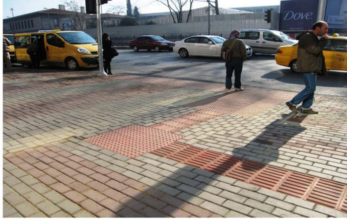
Fotoğraf 21: Görme Engelliler İçin Yapılan Kubbe Kabartılı ve Kılavuz Yol Uygulaması Beşiktaş-Akaretler
