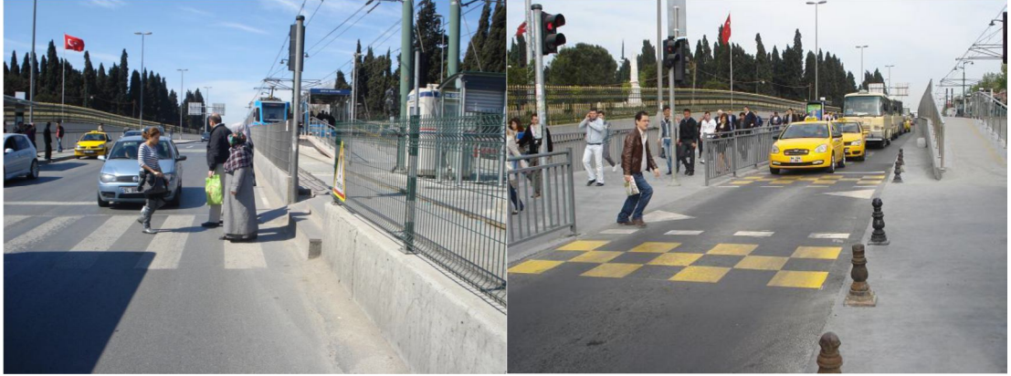
Fotoğraf 16: Edirnekapı İstasyonuna Yapılan Düzenleme (Eski-Yeni Hali)
