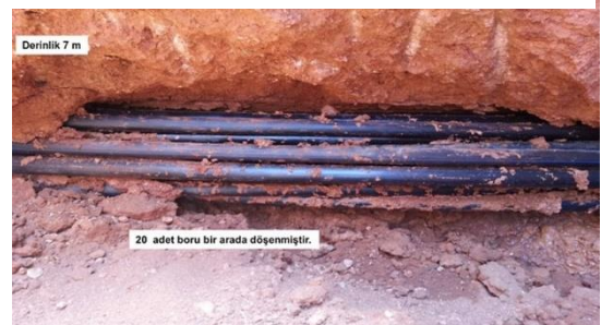
Şekil 18:Kaçak Boru Hattı, Kaynak: Al Jazeera
