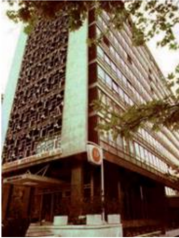
Resim 3. 1. TPAO Genel Müdürlüğü Eski Binası
