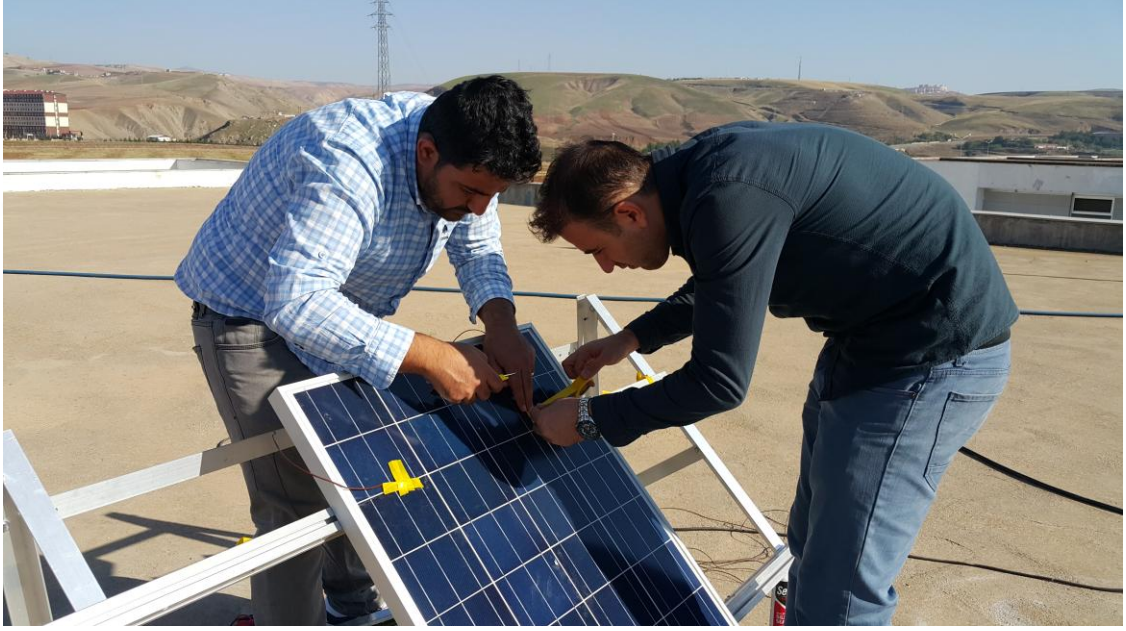
Şekil E2.1 Panele termokupl montajının yapılması
