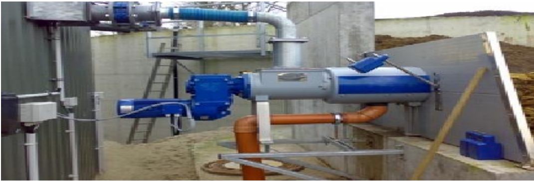
Şekil 6.7. Zorg biyogaz üretim sistemlerinin tesislerinde kullandığı bir tür seperatör (Zorg biyogaz üretim sistemleri, 2015)
