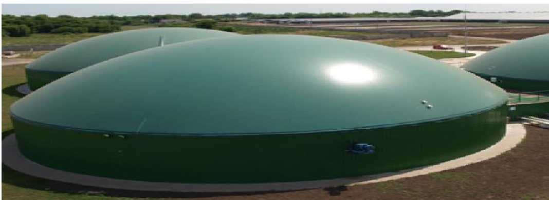
Şekil 6.6. Zorg biyogaz üretim sistemlerinin kurulumunu gerçekleştirdiği bir gaz deposu (Zorg biyogaz üretim sistemleri, 2015)
