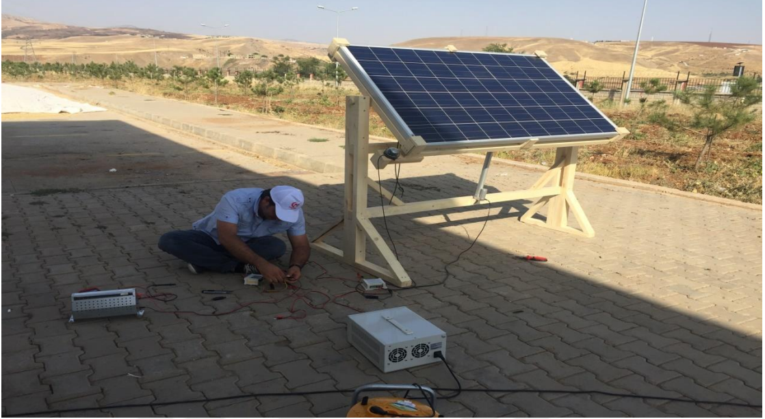
Şekil E5.1. Sistemin kablo bağlantılarının yapılması
