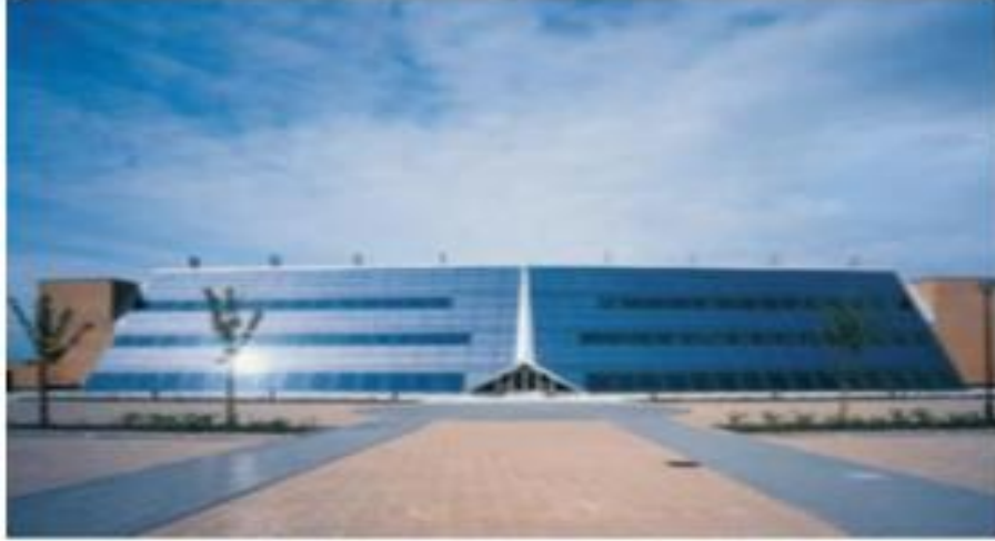
Şekil 3.8 Güney yönüne bakan pv sistemli cephe örneği, (Roberts ve Guarento, 2009)
