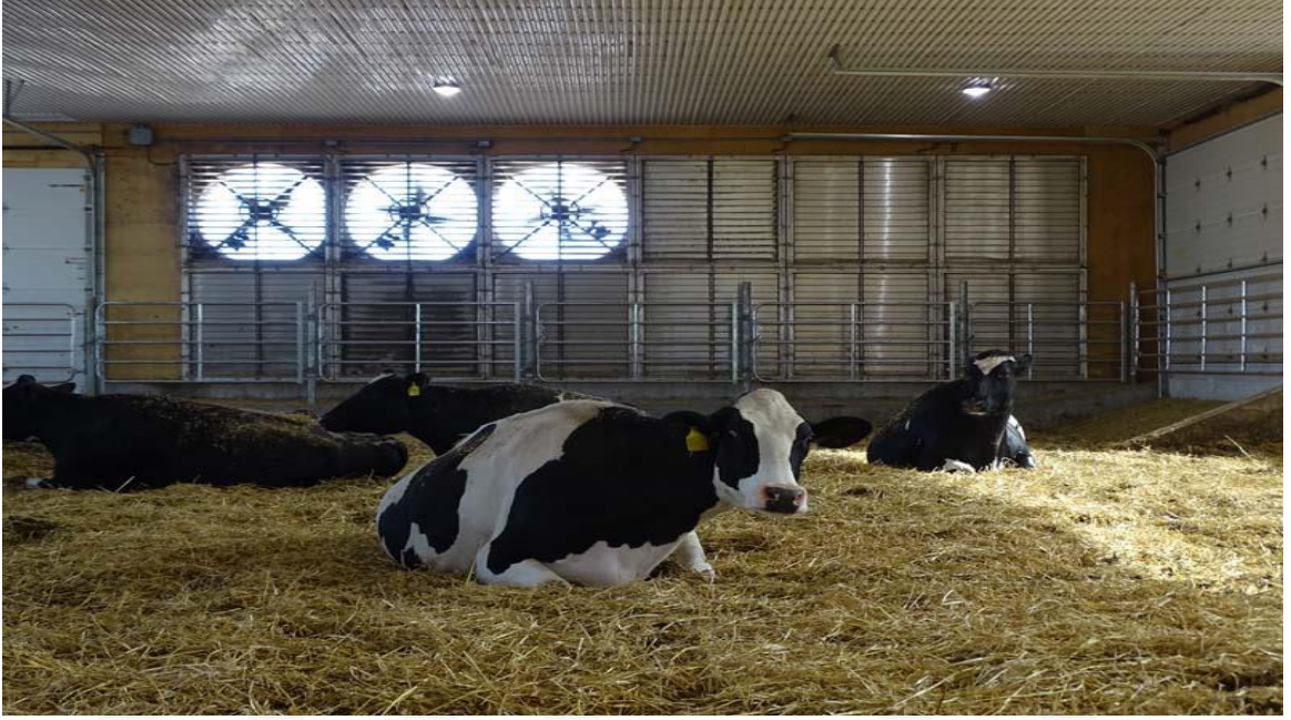
Şekil 2.4. Tünel havalandırma yöntemi (URL-6)
