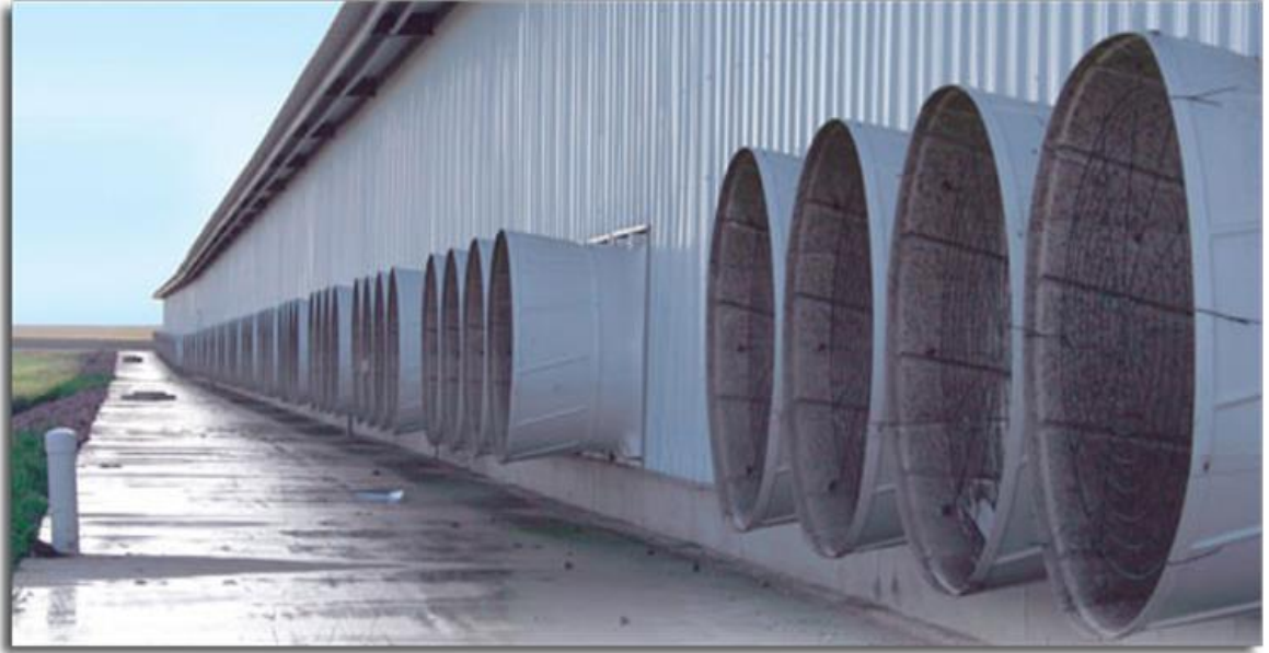
Şekil 2.5. Tünel havalandırma yöntemi (URL-7)
