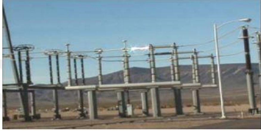
Şekil 1.2. 500 kV'luk bir havalı kesicide oluşan ark görüntüsü
