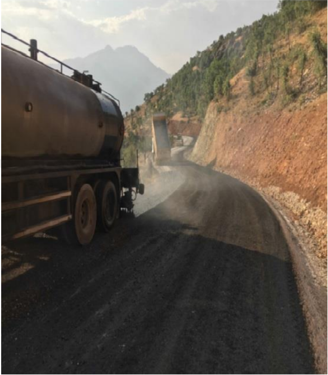
Şekil 3.16. Siirt Merkez Sarı Tepe Köy Yolunun Asfalt Çalışması
