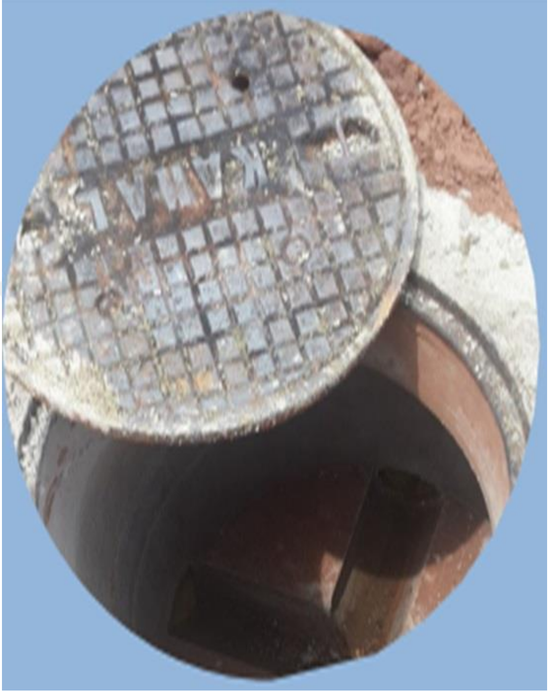
Şekil 3.41. Merkez Dolu Harman Köyü Kanalizasyon Sisteminin Yapımı
