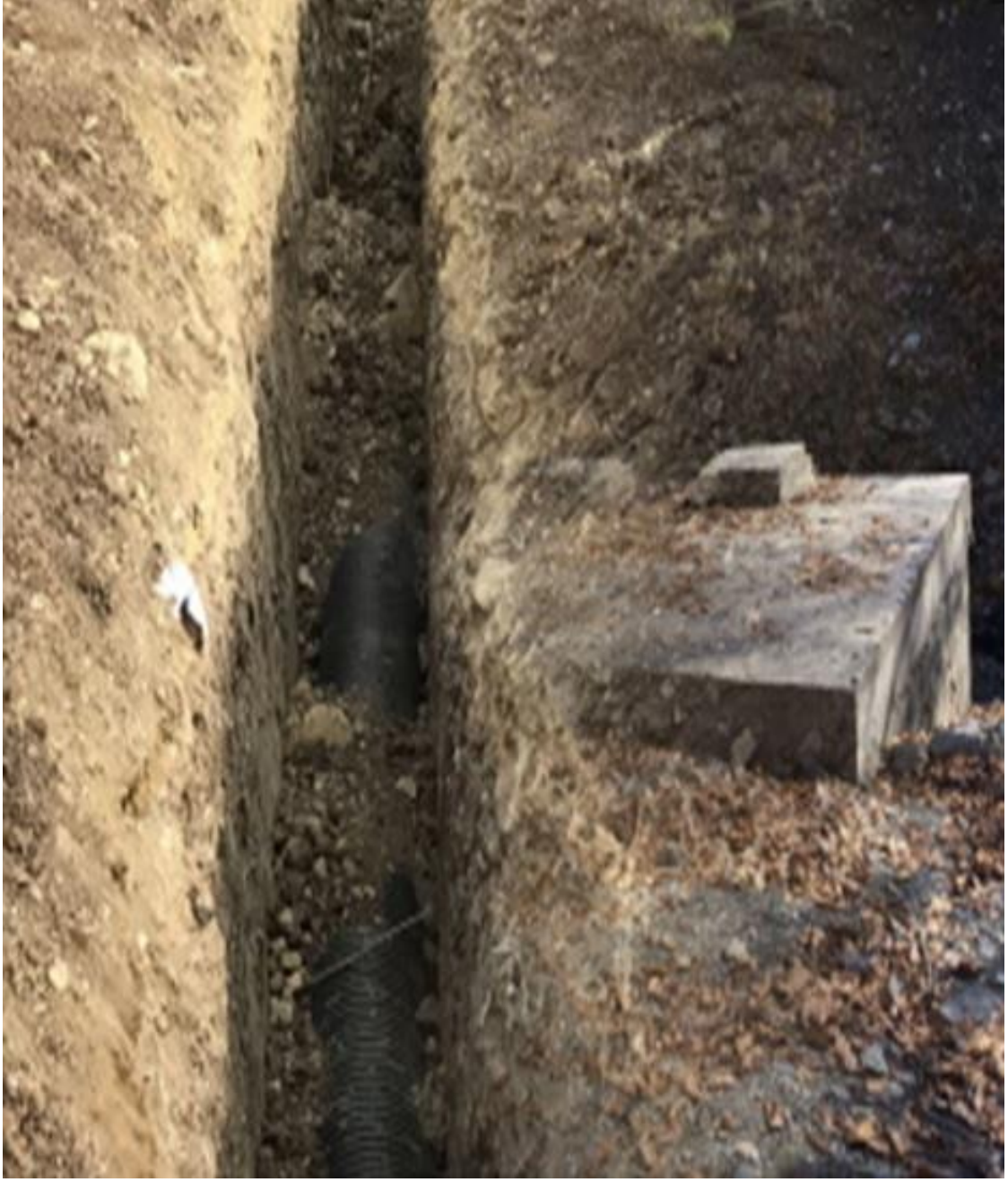
Şekil 3.23. Siirt İli Kurtalan İlçesi Yayıklı Köyüne Kanalizasyon Hattı Döşenmesi
