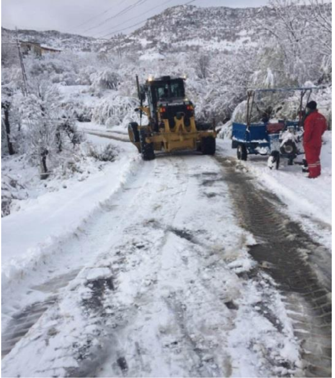
Şekil 3.48. Karla Mücadele Kapsamında Kapanan Siirt İli Pervari İlçesi Çavuşlu-Dolusalkım Yollarının Açılması
