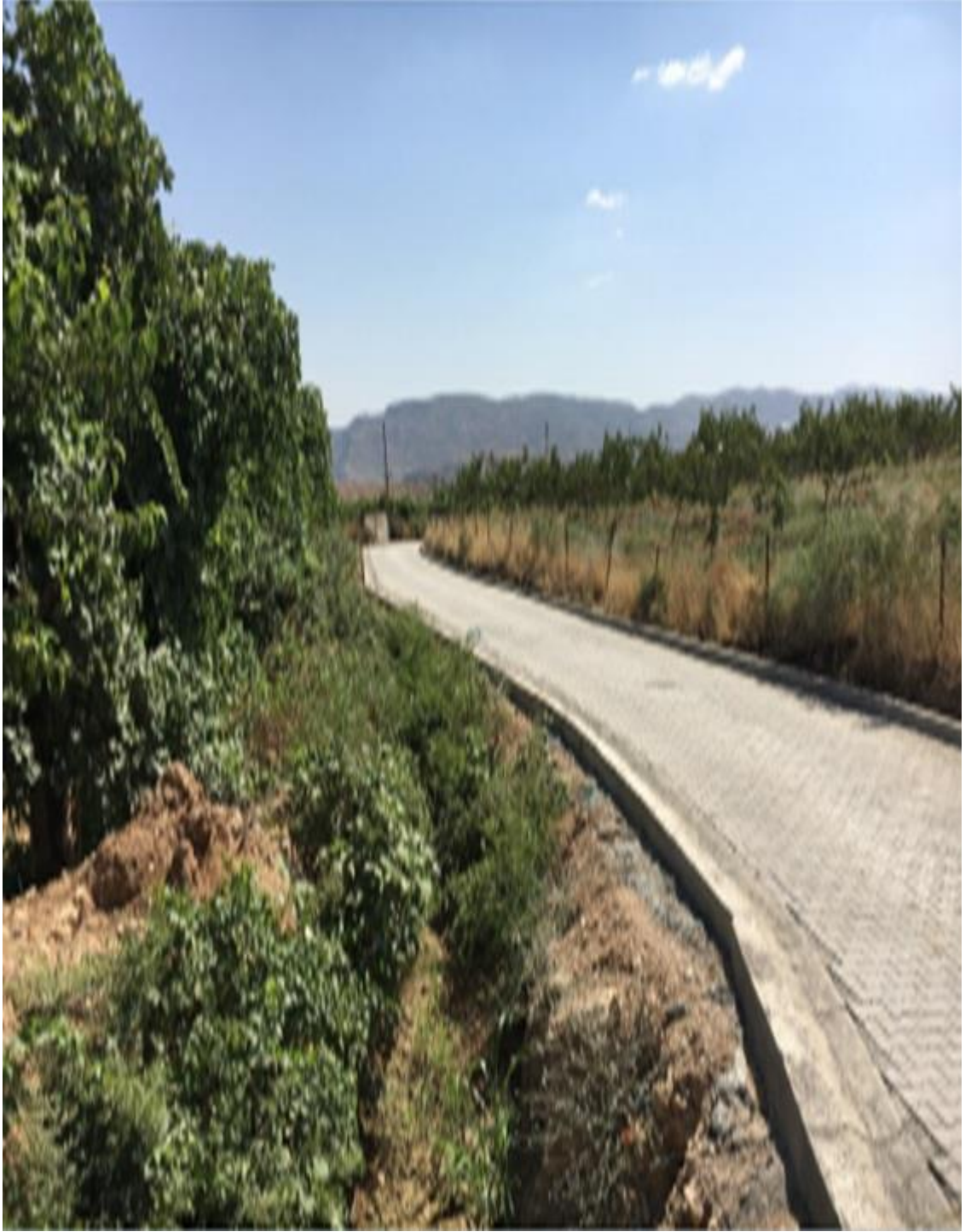
Şekil 3.31. Siirt İli Şirvan İlçesi Yolbaşı Köyü Yolu Parke Yapım Çalışması
