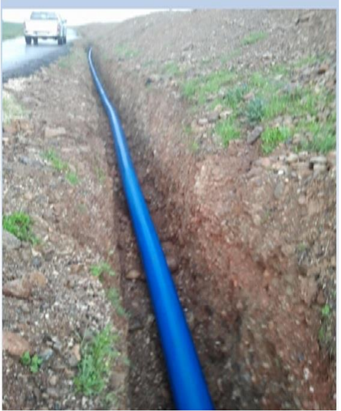
Şekil 3.20. Siirt Merkez Tuzkuyusu Köyü Grup İçme Suyu Hattı Döşenmesi
