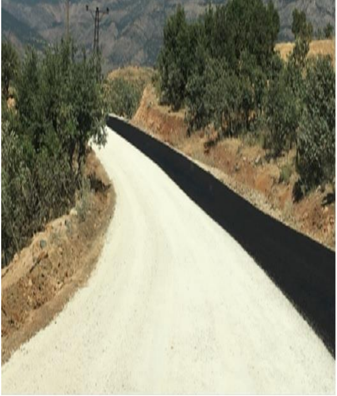
Şekil 3.29. Siirt İli Şirvan İlçesi Yağcılar Köyü, Köy Yollarına Stabilize ve Asfalt Döküm Çalışması
