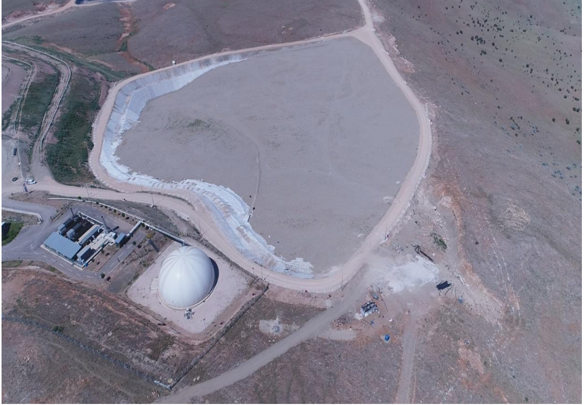
Şekil 4. 13: Katı Atık Bertaraf Tesisi
