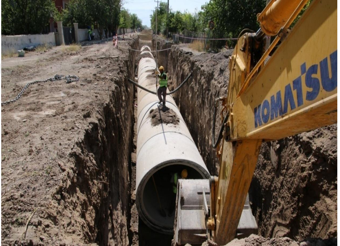
Şekil 4. 29:Şorşor Deresi Kanal Çalışması
