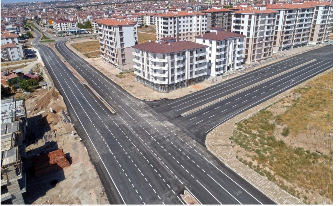
Şekil 4. 24:Asfalt İşleri Yapımı
