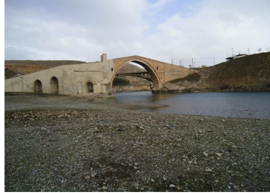
Şekil 28. 26 nolu istasyon, Batman Suyu
