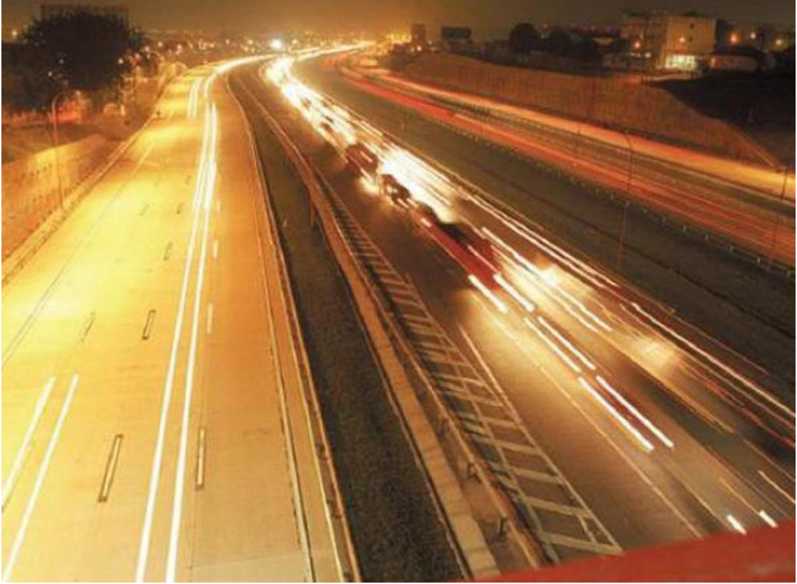
Şekil 12. Brezilya'daki bir yol, beton (sol) ve asfalt beton kaplamaların albedo farkını göstermektedir (Boztepe, 2011).
