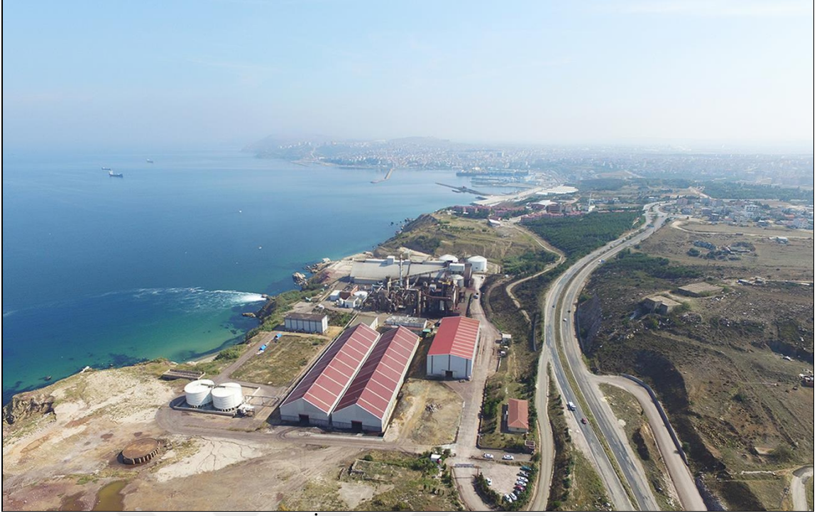
Şekil 23. Balıkesir Bandırma Bor İşletme Müdürlüğü görünüşü (URL-5).
