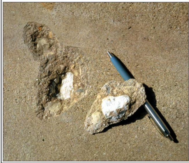
Şekil 17. Beton yüzeyindeki bir açılma (Boztepe, 2011).
