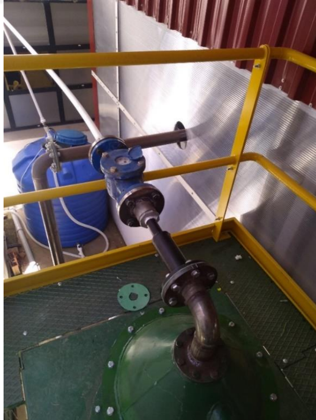
Şekil 18. Soğutucu akışkanın debi ölçümü.
