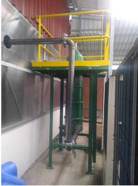
Şekil 14. Montajı yapılmış yıkama ünitesine ait a)gaz giriş b)gaz çıkış görünümü.
