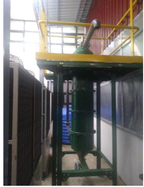
Şekil 14. Montajı yapılmış yıkama ünitesine ait a)gaz giriş b)gaz çıkış görünümü.
