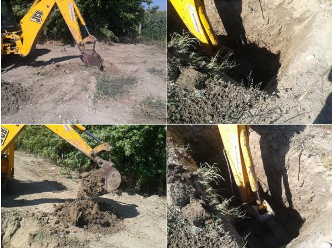
Şekil 3.1. Muayene Çukuru Açılması (YMÇ)
