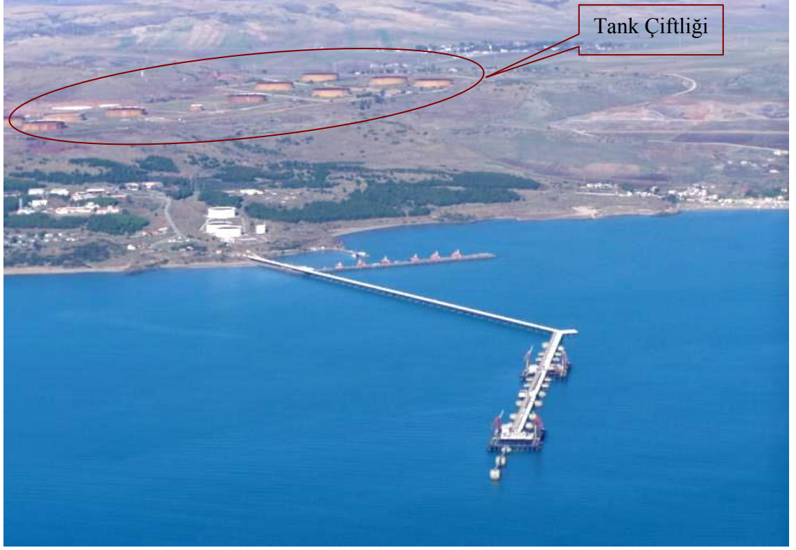
Şekil 3.13. Botaş Petrol İşletmeleri Bölge Müdürlüğü Genel Görünüşü
