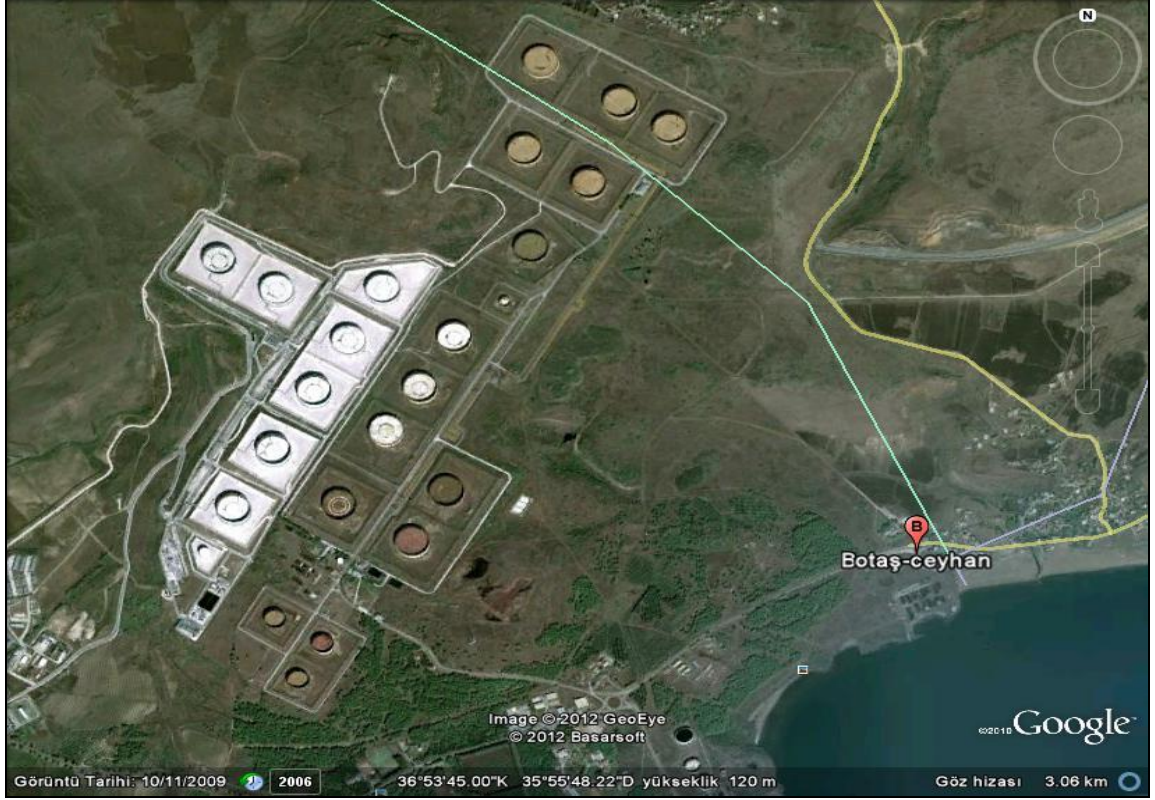
Şekil 3.17. BOTAŞ Petrol İşletmeleri Bölge Müd.Tank Çiftliği Görünümü
