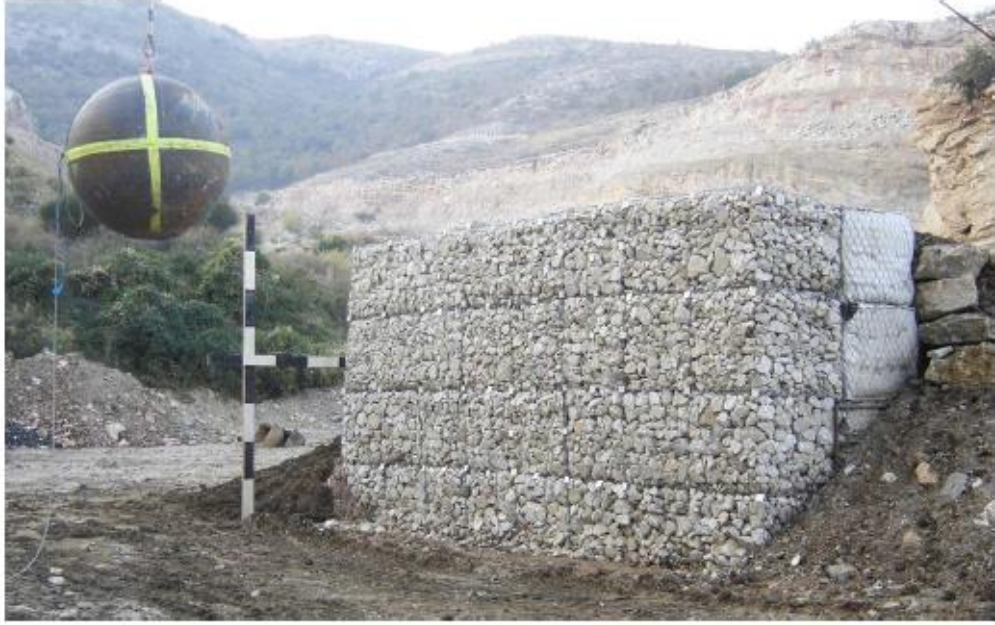
Şekil 2.15. Toprak dolgu setin önüne örülen taş duvar [27]
