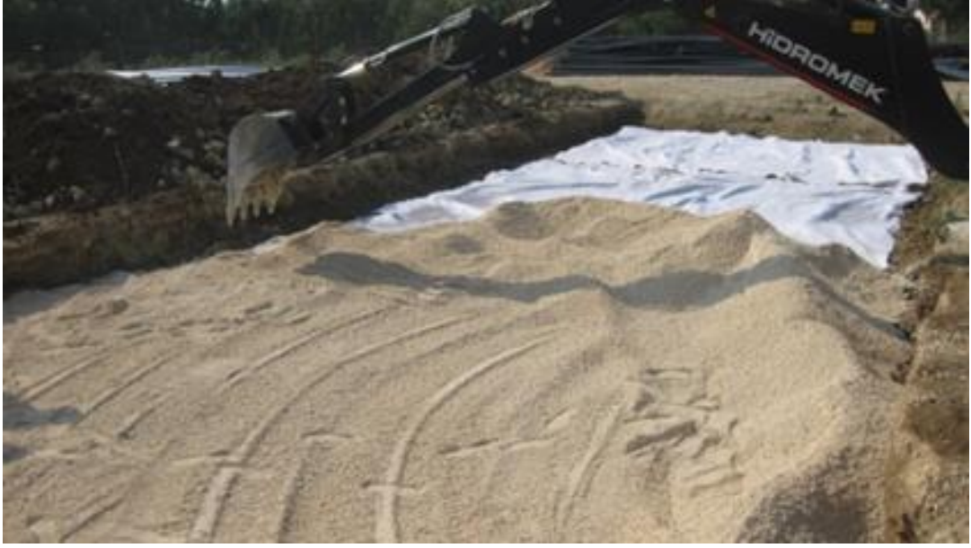
b) Granüler Dolgu Malzemesinin Kazı Sahası İerisine Serilmesi
