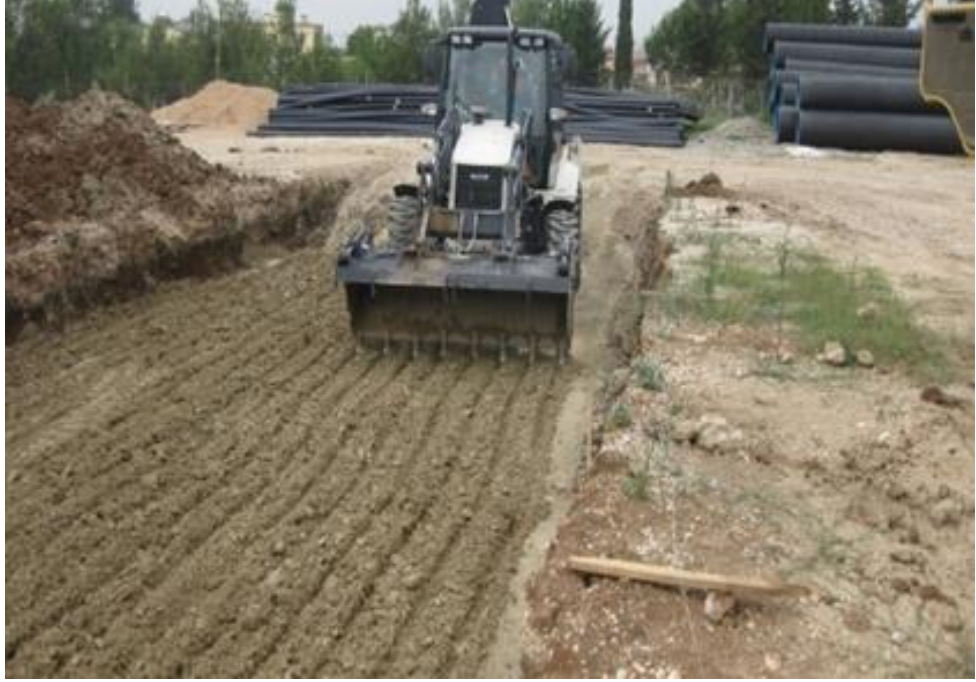
Şekil 3.27. Kil Yüzeyinin Tırmıklanıp Homojenliğinin Sağlanması
