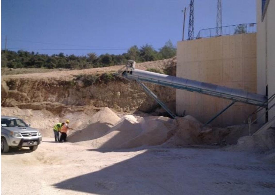
a) Taş Ocağı Üretim Tesisi
