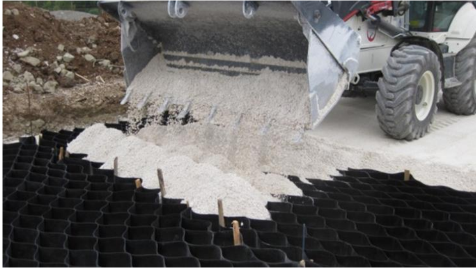
a) Geocell İle Güçlendirilmiş Yol Kesitinin Oluşturulması
