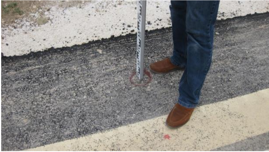
Şekil 3.43. Nivo Aleti Kullanılarak Kot Okumalarının Yapılması
