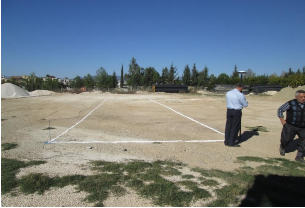
Şekil 3.18. Kazı Öncesi Zemin Üst Kotlarının Belirlenmesi
