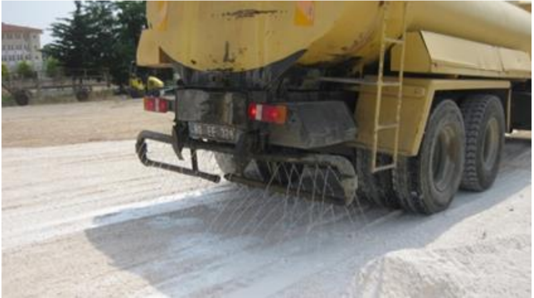
Şekil 3.33. Granüler Dolgu Malzemesinin Serilmesi ve Su İçeriğinin Ayarlanması
