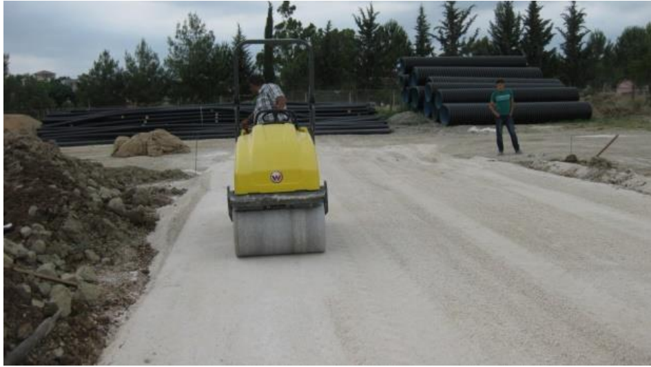
Şekil 3.37. Yüzeyin Düzeltilmesi (Üst Fotoğraf) ve Tabakaları Sıkıştırma İşlemi (Alt Fotoğraf)
