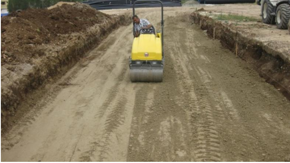
Şekil 3.24. Yol Taban Zeminin Sıkıştırılması
