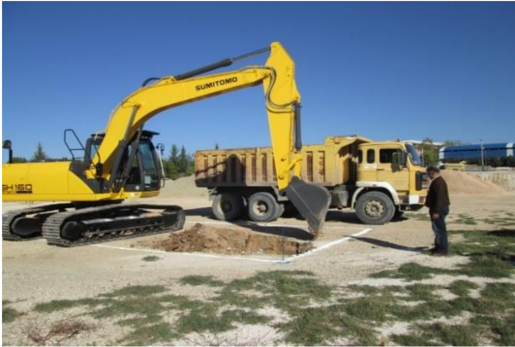
Şekil 3.19. Kazı Öncesi Zemin Üst Kotlarının Belirlenmesi
