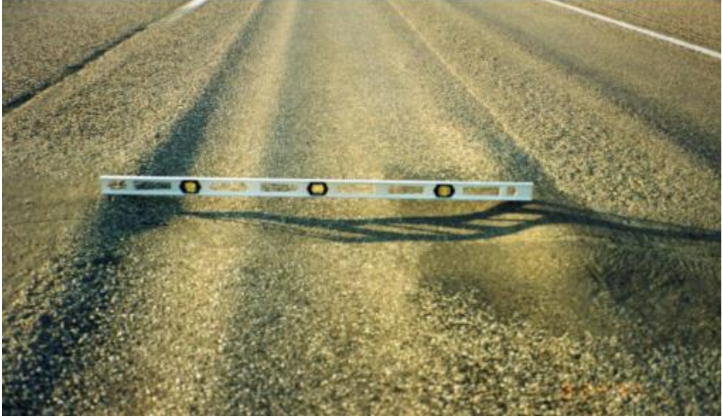
Şekil 1.1. Yol Boyu Oluşan Tekerlek İzi Örneği (İsfalt, 2002)
