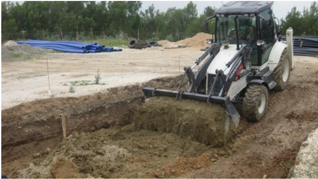
Şekil 3.23. Yol Taban Zeminin Serilmesi
