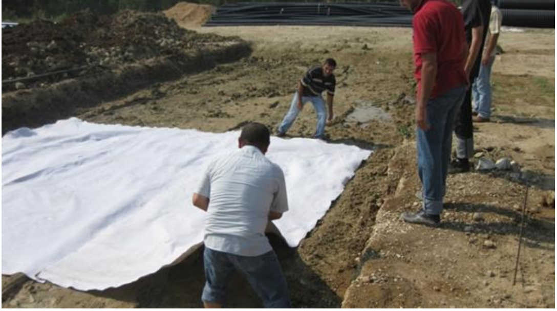
Şekil 3.34. Geotekstil Serilmesi
