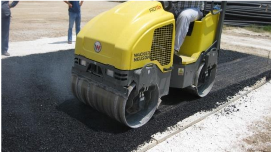
Şekil 3.39. BSK Kaplama İnşası
