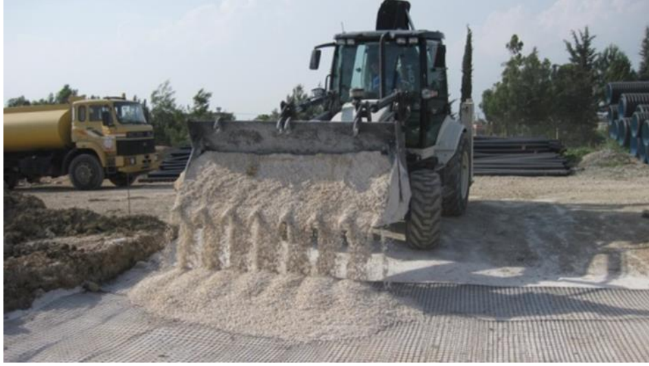
b) Geogrid İle Güçlendirilmiş Yol Kesitinin Oluşturulması
