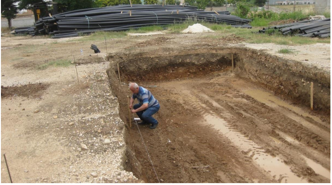
Şekil 3.22. Kil Dolgu Kotunun Belirlenmesi
