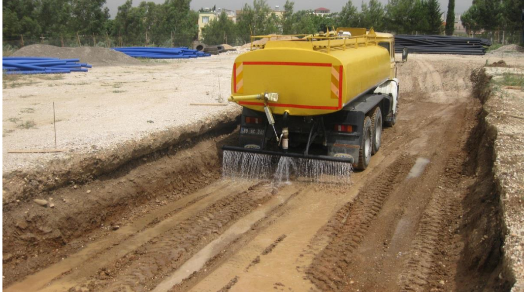
Şekil 3.21. Kazı Tabanının Sulanması
