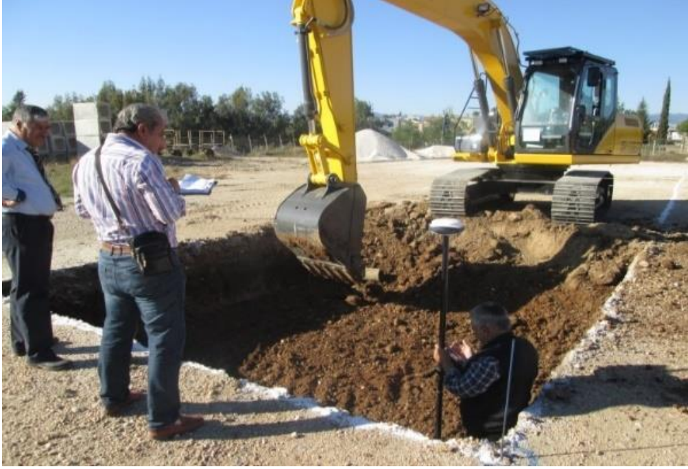
Şekil 3.20. Kazı Derinliğini Belirlemek İçin Kazı Tabanı Kotlarının Alınması
