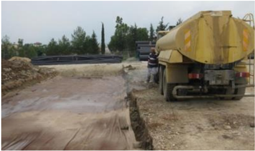
Şekil 3.31. Yol Taban Zeminin Kaplanması ve Islatılması
