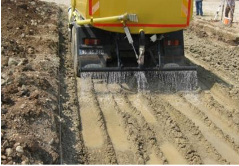
Şekil 3.28. Yol Taban Zemininin Sulanması
