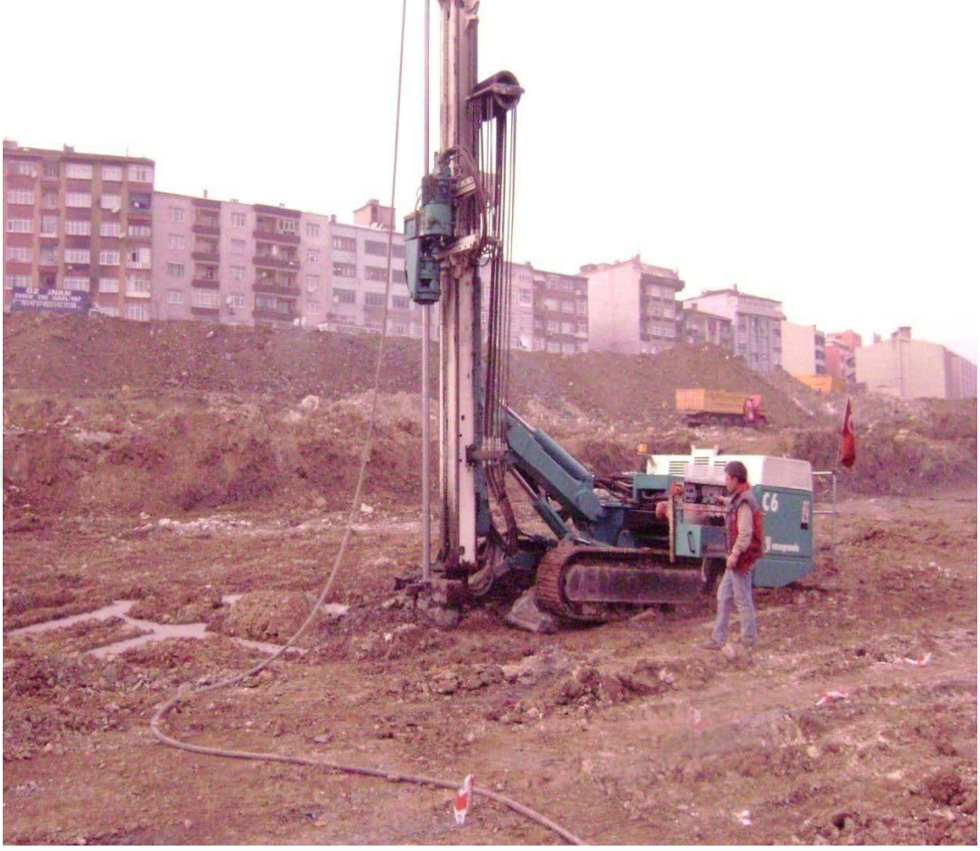
Şekil 2.18 Çift akışkanlı jet grout uygulaması [18]
