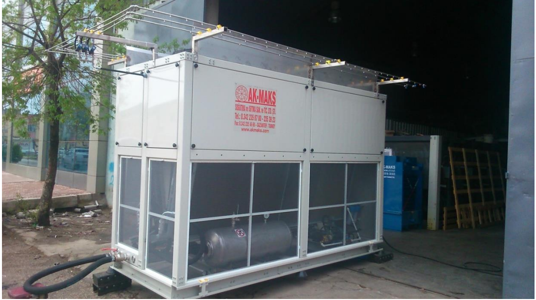
Şekil 3.10. Üretimi yapılmış ıslak kuru soğutucu
