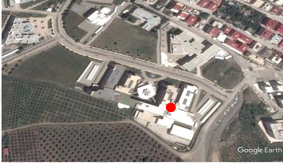
Şekil 4.1. OKÜ Mühendislik Fakültesi binası uydu görüntüsü
