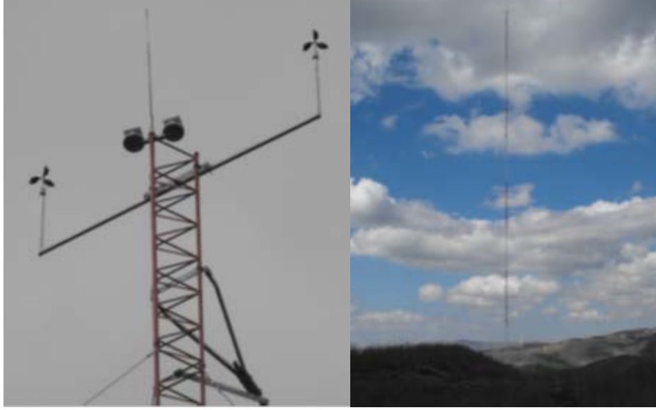
Şekil 3.3. Rüzgâr sensörlerinin ölçüm direğine yerleştirilmesi
