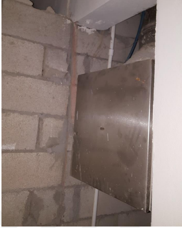
Şekil 6.5. Binaya çöp bacası eklenmesi
