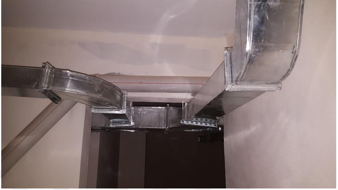
Şekil 6.7. Binadaki pis su boruları ve havalandırma kanallarının görünümü
