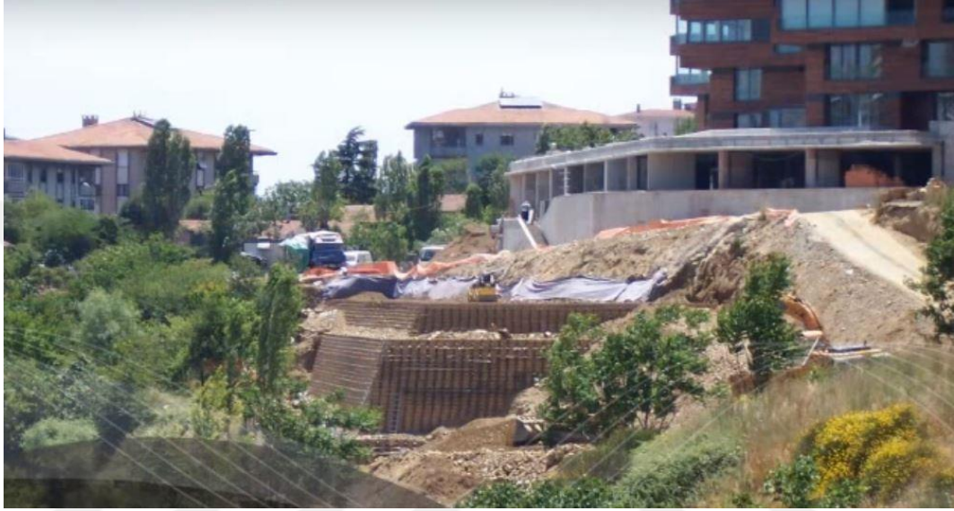
Şekil 1.2. Geocell dayanma duvarının 2. kademesi inşa edilirken görüntüsü (PRS Geotechnologies 2009)
