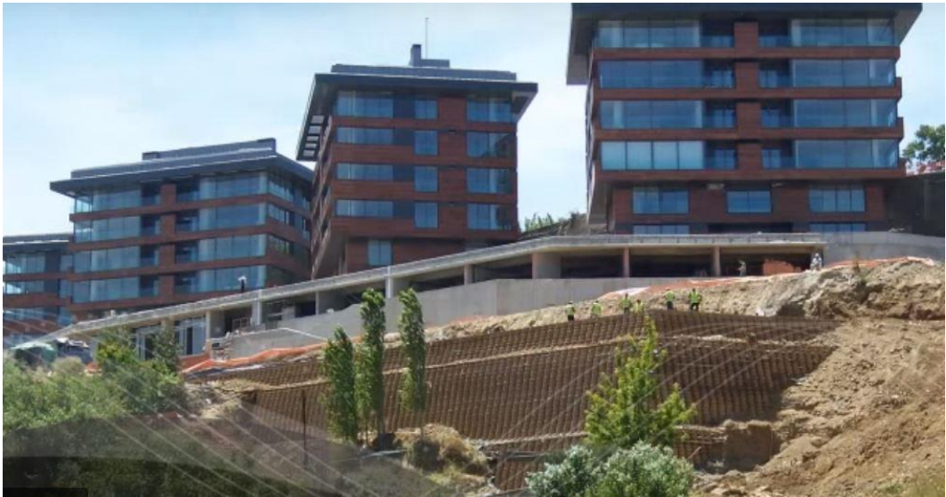
Şekil 1.3. Geocell dayanma duvarının 3. kademesi inşa edilirken görüntüsü (PRS Geotechnologies 2009)
