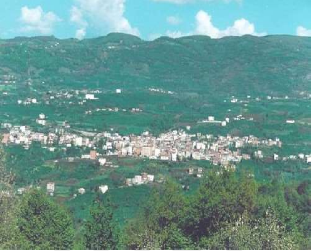
Resim 21: Aybastı ilçesinin genel görünümü
